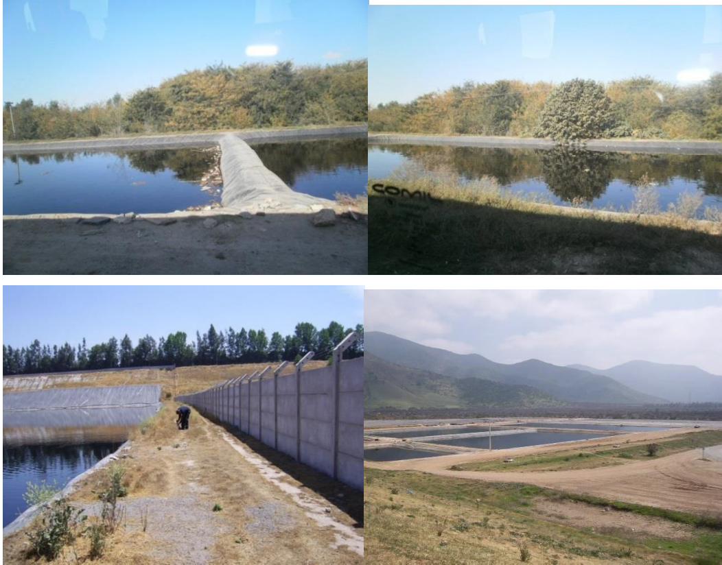
Figura 6. De izquierda a derecha y de arriba hacia abajo. Piscina de percolado en el CEAMSE, Buenos Aires, Argentina. Piscina liquido percolado relleno sanitario cerrado Lepanto, San Bernardo, Chile. Bandejas de evaporación de líquidos percolados, relleno Sanitario Santiago Poniente, Chile. Fotos: Lucrecia Brutti.
