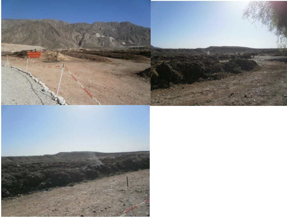
Figura 7. De izquierda a derecha y de arriba hacia abajo. Emplazamiento de pilas y máquina volteadora. Acopio de material degradado. Foto: Lucrecia Brutti.
