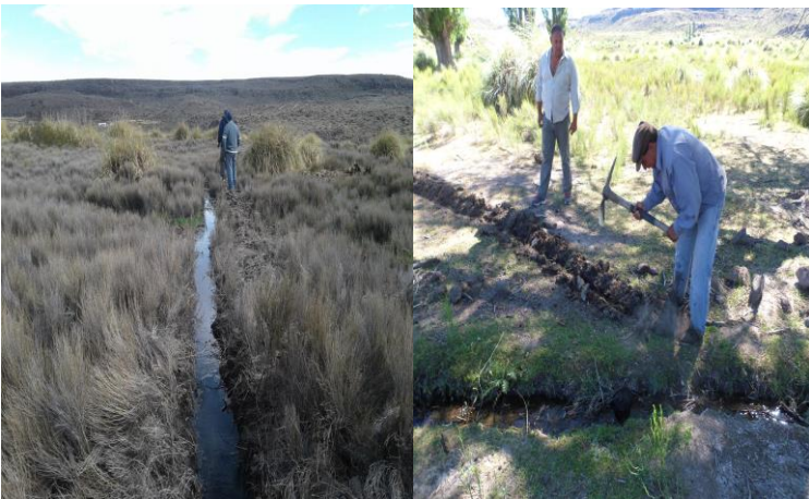
Figura..... Agua en los canales sobre el mallín (Izquierda). Realización de canales con pala y pico (Derecha).
