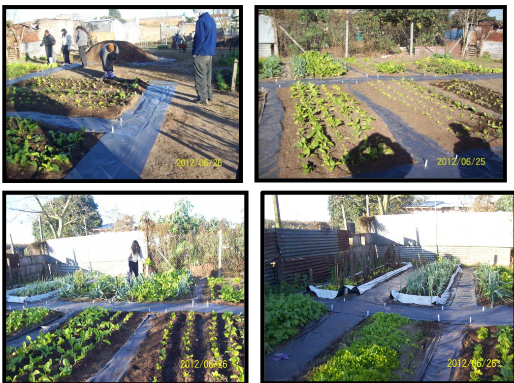
Figura 3. Vistas del proceso de aislación del suelo contaminado con la geomembrana.
