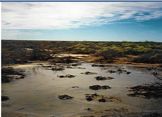
Antigua laguna de evacuación de efluentes
