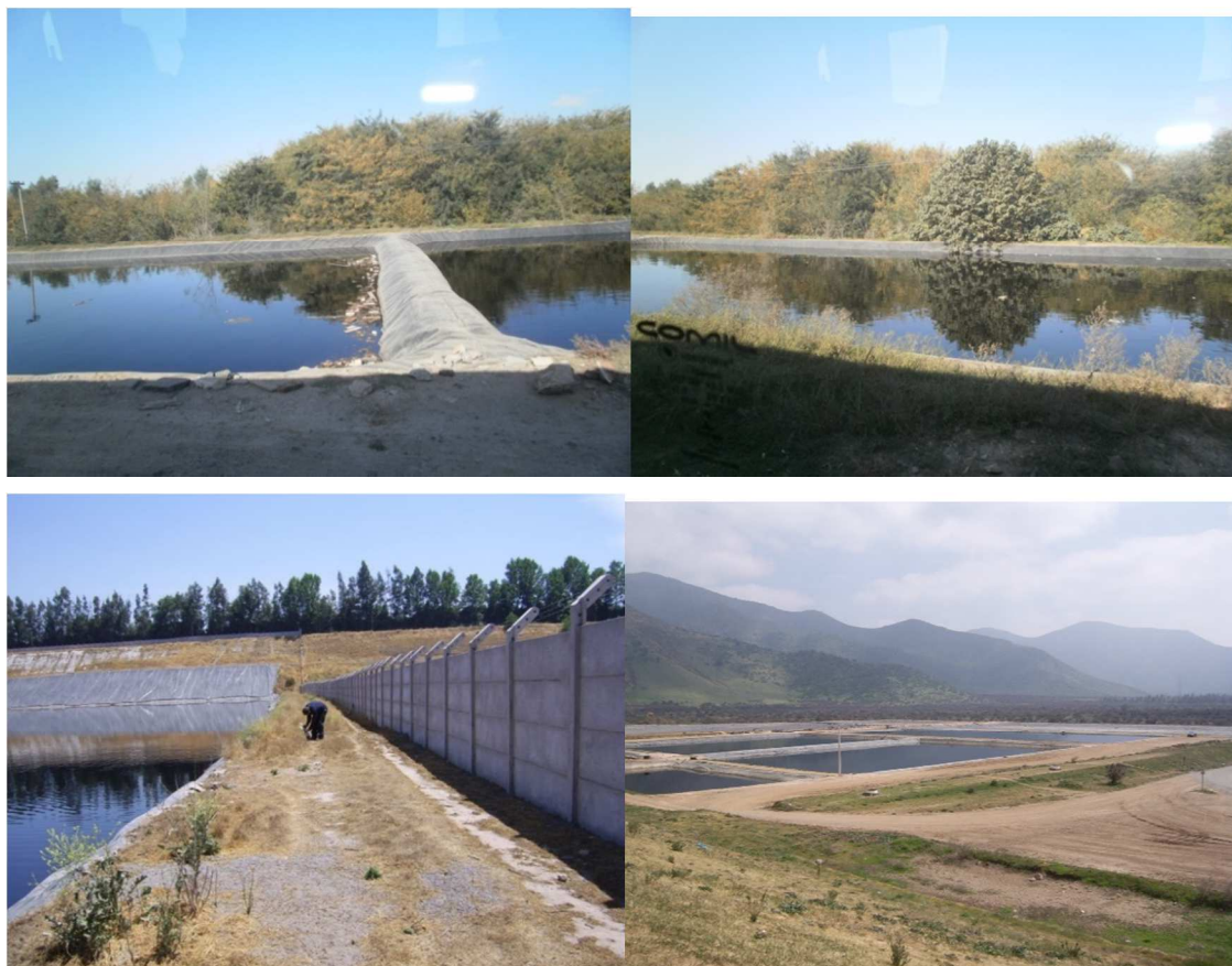
Figura 6. De izquierda a derecha y de arriba hacia abajo. Piscina de percolado en el CEAMSE, Buenos Aires, Argentina. Piscina líquido percolado relleno sanitario cerrado Lepanto, San Bernardo, Chile. Bandejas de evaporación de líquidos percolados, relleno Sanitario Santiago Poniente, Chile. Fotos: Lucrecia Brutti.
