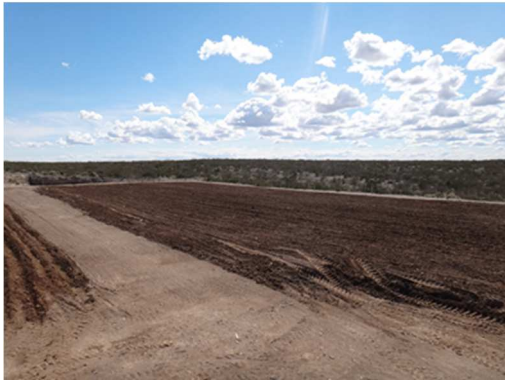
Construcción de celdas
