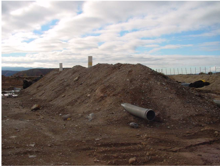
Figura 5. Biopila típica en construcción con cañerías de aireación vertical y horizontal para estimular la degradación de hidrocarburos en suelos contaminados.
