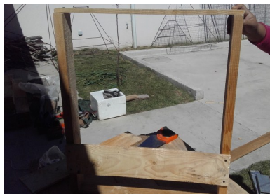
Foto 8: Estructura de madera
