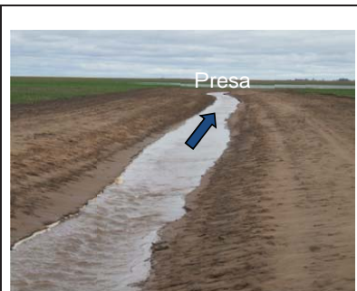
Figura 19. Badén simple construido en el 2006, drenando excedentes hídricos hacia la Presa, septiembre 2007.
