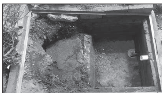
Figura 3: Obra de captación de vertiente.
