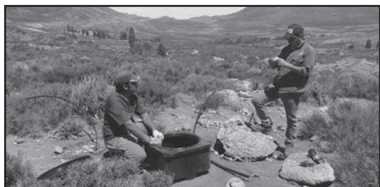
Figura 4: Armado del sistema de conducción del agua. Tanque intermedio de derivación.
