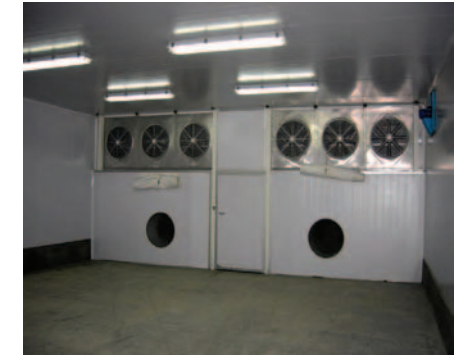
Túnel de enfriado
