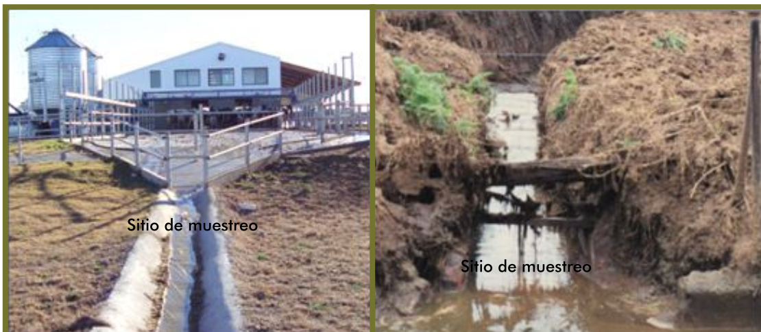
Figura 10. Descarga de los efluentes del corral de espera directamente al canal de cemento (foto izquierda) o de tierra (foto derecha).
