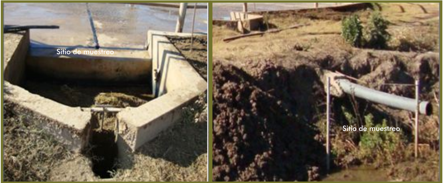
Figura 9. Cámara de recepción de los efluentes de la instalación de ordeño.
