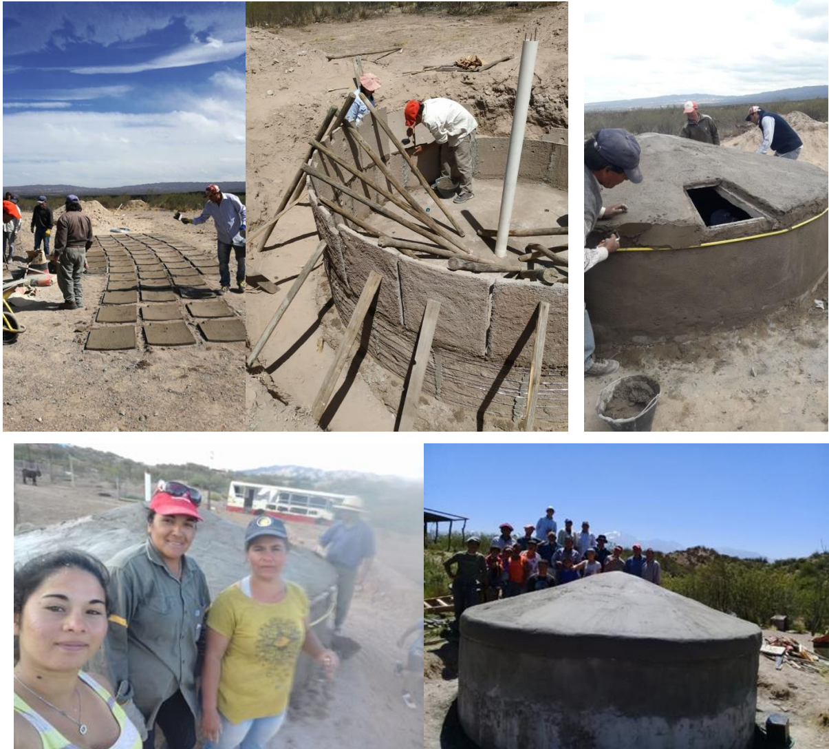
Imágenes 27 - 31. Construcción comunitaria de cisternas en Cacheuta Sur. 2019 y 2020. (fotos Pablo Bauzá)
