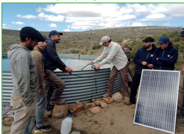
Figura 3: Encuentro en Cerro Alto, instalando una bomba de agua con energía solar.
