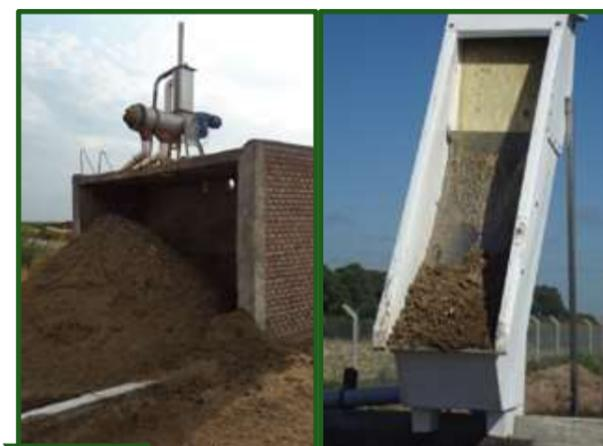
**Figura 18-3** Sistemas de separación de sólidos: tornillo (izquierda) y tamiz (derecha).
