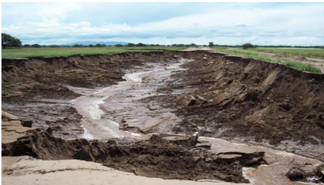
Figura 3: Colapso de la napa freática y apertura del Río Nuevo sobre Ruta Provincial N°33 en el año 2008.
