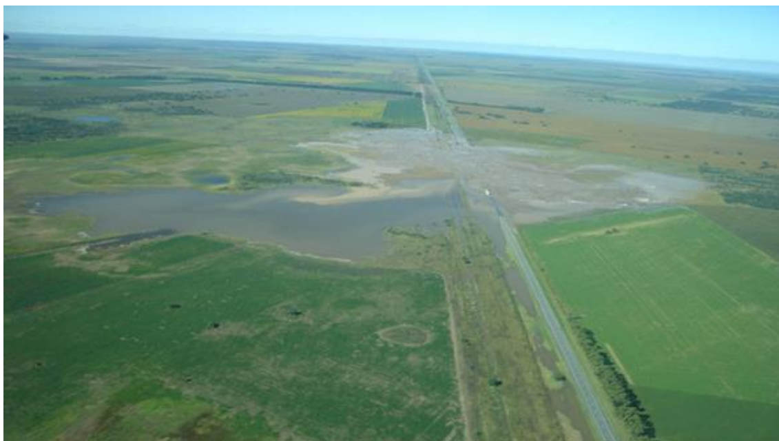
Figura 6: Sedimentación en la cuenca baja sobre la Ruta Nac. N.º 8 en el año 2008.
