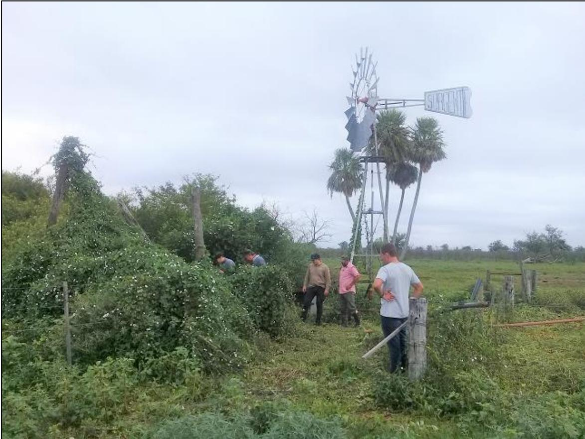
Sistema "patas de araña" de la Aguada Sosa con pozo calzado dentro de la abundante vegetación con molino surgente con torre baja.
