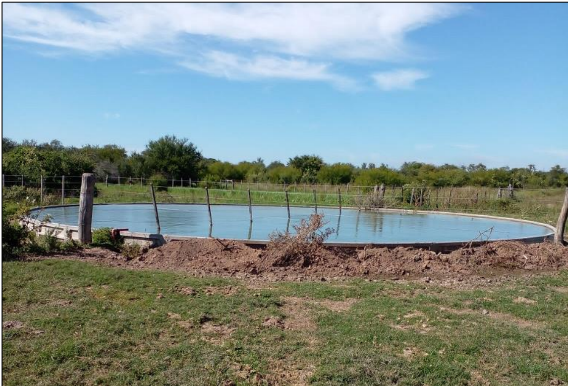
Tanque bebedero de la Aguada de La Torre de 80.000 litros de capacidad
