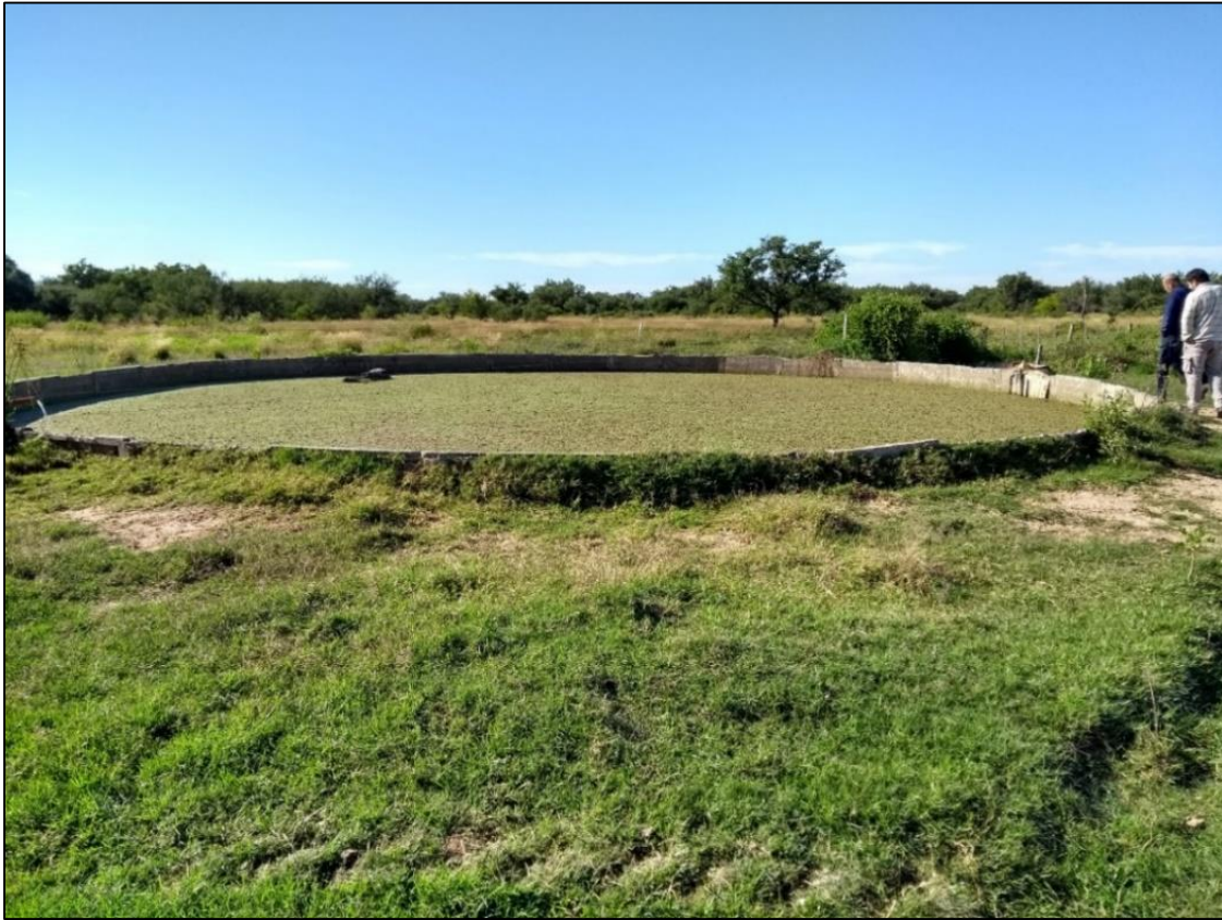
Tanque bebedero de 100.000 litros de capacidad.
