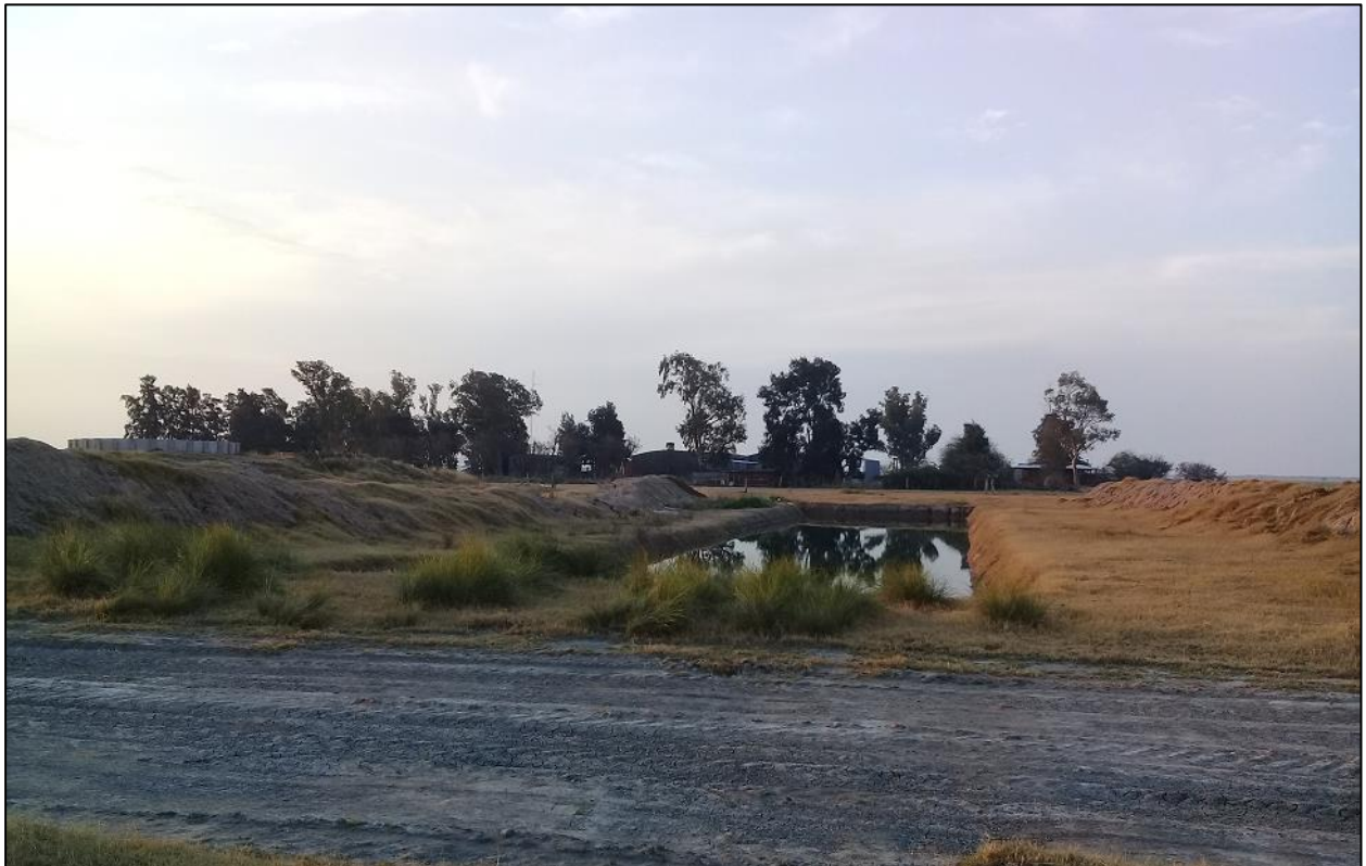
Represa y tanque elevado en el sector del Casco.
