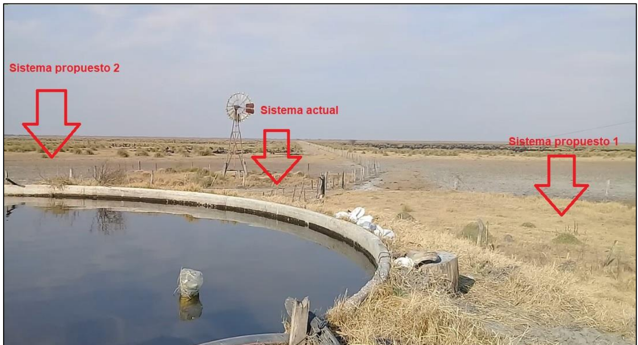
Tanque elevado del Lote 1 con sistemas de acceso al agua subterránea actual y propuestos.
