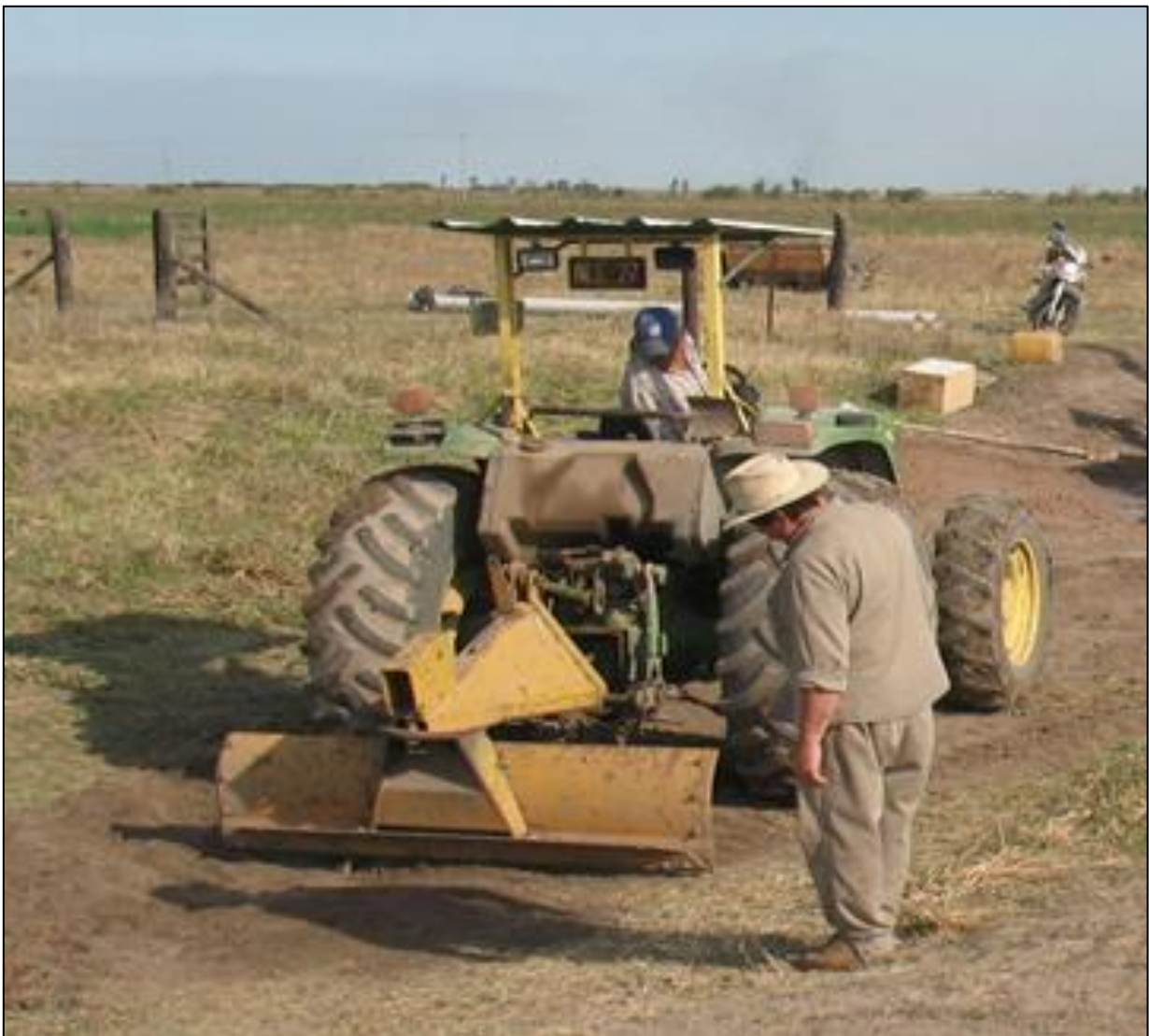
Herramienta para sistematizar el área de las perforaciones para facilitar la recarga.
