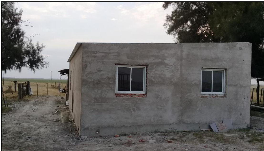
Construcción de nueva casa para el Personal del Establecimiento.
