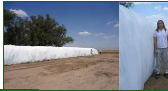
Figura 8-93 Vista de la bolsa de heno, donde se destaca la verticalidad de la pared.
