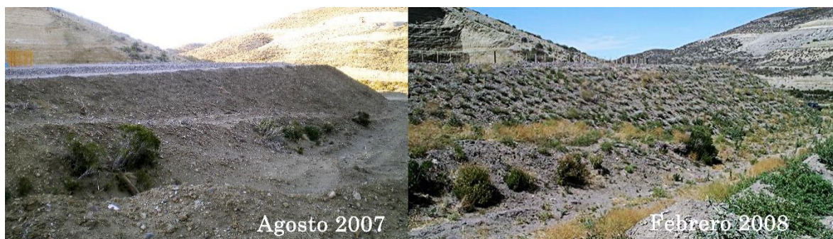
Figura 14. Vista inicial del talud con las barreras protectoras (izq.) y luego de revegetado (der.).
