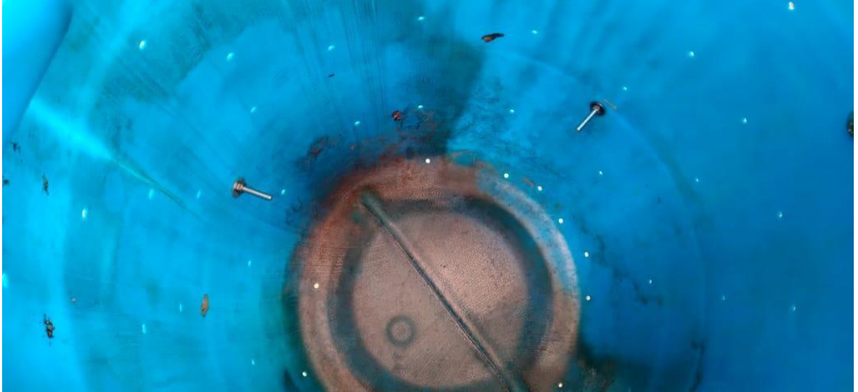
Figura 7. Vista interior de la posición agitadores internos. Base del cilindro (medio-inferior).
