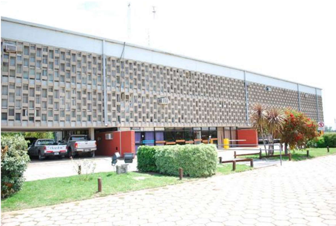
Figura 1: Edificio de la EEA Rafaela
