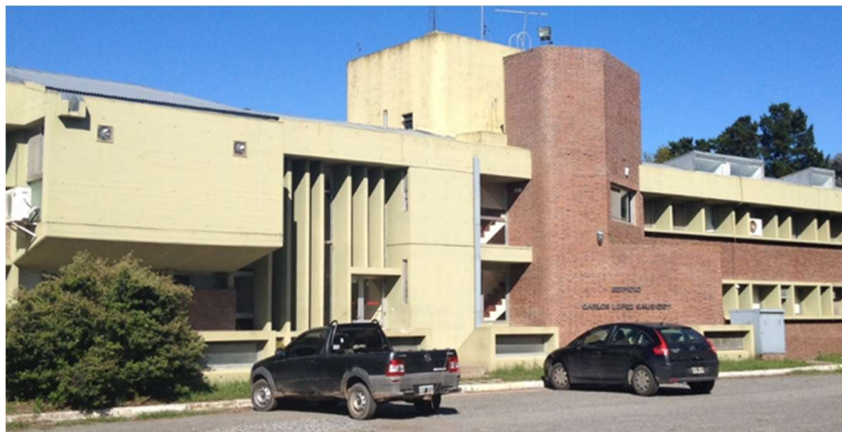
Figura 1: Vista del edificio de Producción Animal donde se encuentra el Laboratorio de Virología.
