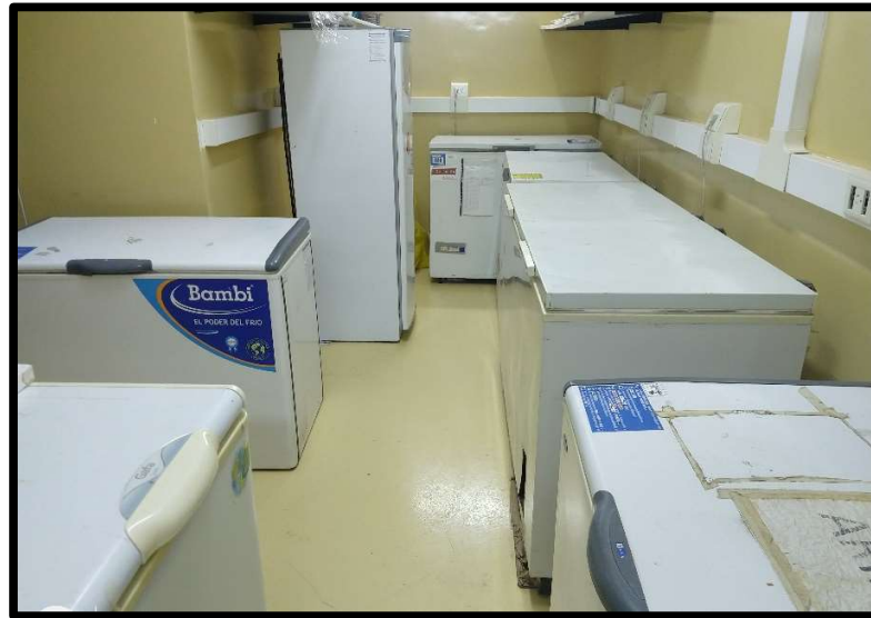
Figura 19: Sala de freezers destinada a la conservación del material genético.
