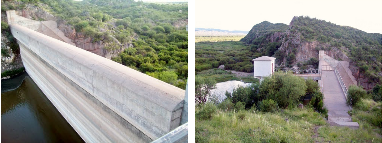
Figuras N° 15 - 16: Fotografías panorámicas del Dique El Portezuelo
