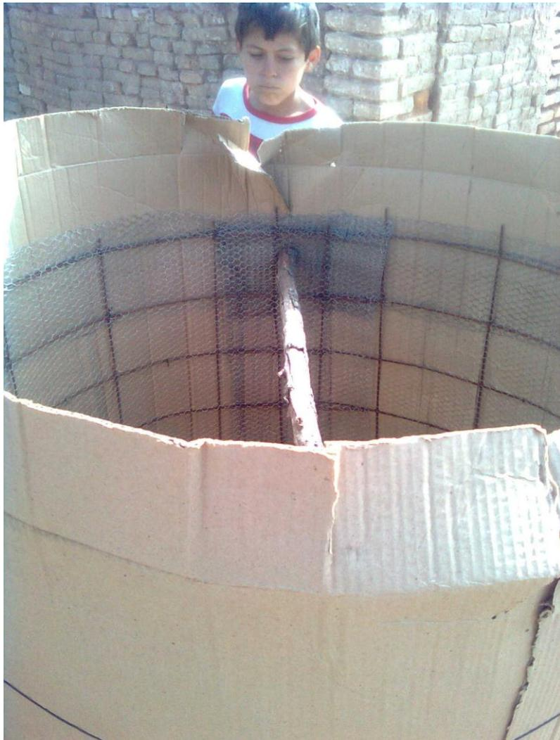
**Estos tanques pueden construirse arriba del suelo o enterrados. Si se los entierra, los tanques resultan más fáciles de construir y más resistentes.**
