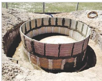
Taller de construcción de cisternas de placa en las comunidades rurales del dpto. Rosario Vera Peñaloza.
