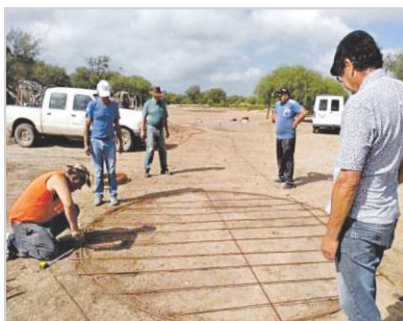
Taller de construcción de cisternas de placa en las comunidades rurales del dpto. Rosario Vera Peñaloza.
