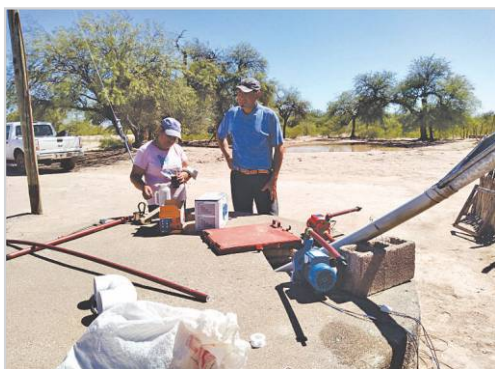
Tapas de piletas e instalación de bombas en La Envidia.
