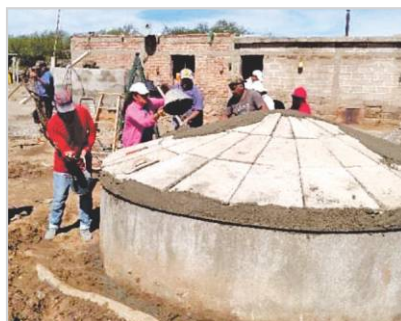
Taller de construcción de cisternas de placa en las comunidades rurales del dpto. Rosario Vera Peñaloza.
