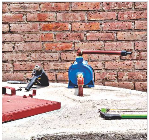
Tapas de piletas e instalación de bombas en La Envidia.
