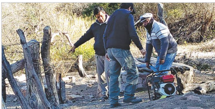
Acondicionamiento de obras en las comunidades rurales.
