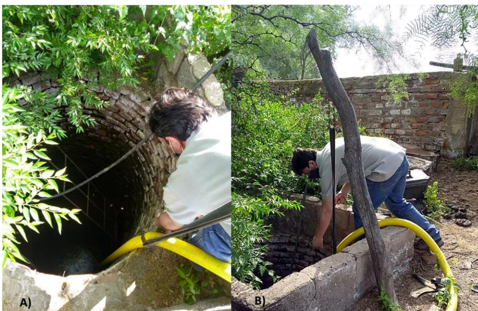
**Imagen 2A y 2B:** La imagen representa el pozo de agua del establecimiento La Purísima, se observan paredes de ladrillos, brocal sin tapa y personal técnico realizando mediciones.
