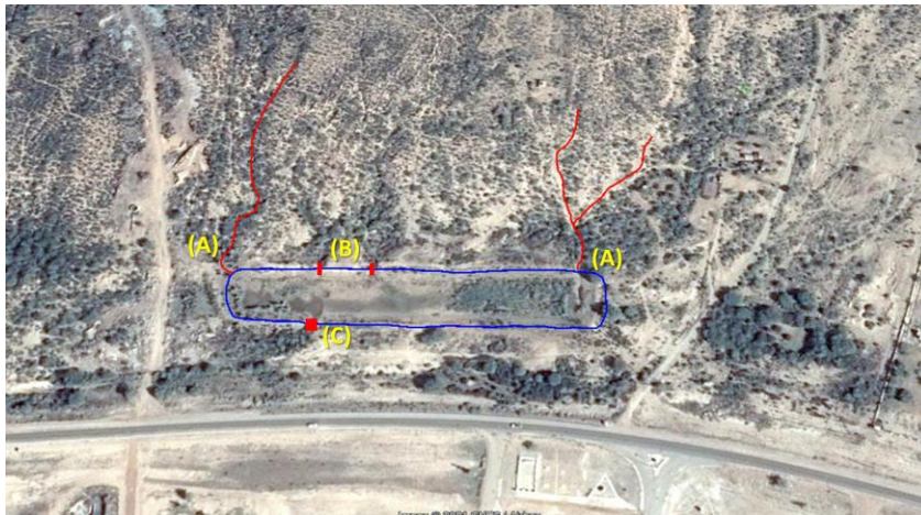
Imagen 4: Detalles de represa comunitaria próxima al acceso de la Villa Santa Rita de Catuna, Dpto. Gral. Ocampo. (A) Vías de entrada de agua; (B) roturas incipientes en bordo perimetral; (C) Corte total de bordo por exceso de agua.
