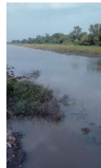
Sitio 5. Alcantarilla cubierta con agua.
