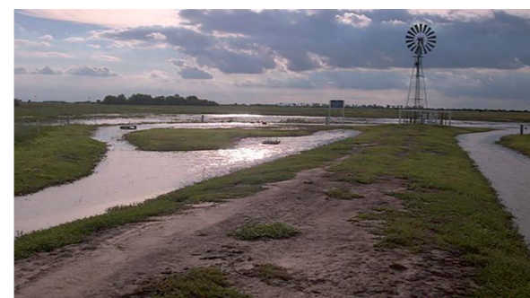
Fig. 1: Sistema A: camino doble propósito para efectuar la recarga del acuífero con perforaciones doble propósito.
