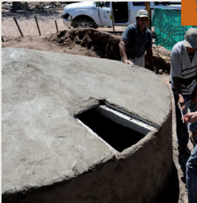
Alrededor de la placa donde se instalará la puerta realizamos una mocheta o marco para evitar que el agua escurra y se meta a la cisterna directamente desde arriba, la protege de la tierra y facilita la colocación de la puerta.
