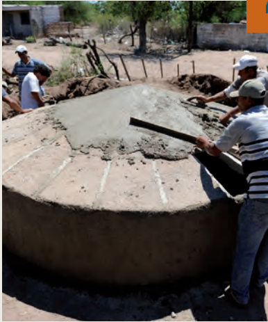
Completamos el revoque de toda la cisterna con el mismo material.
