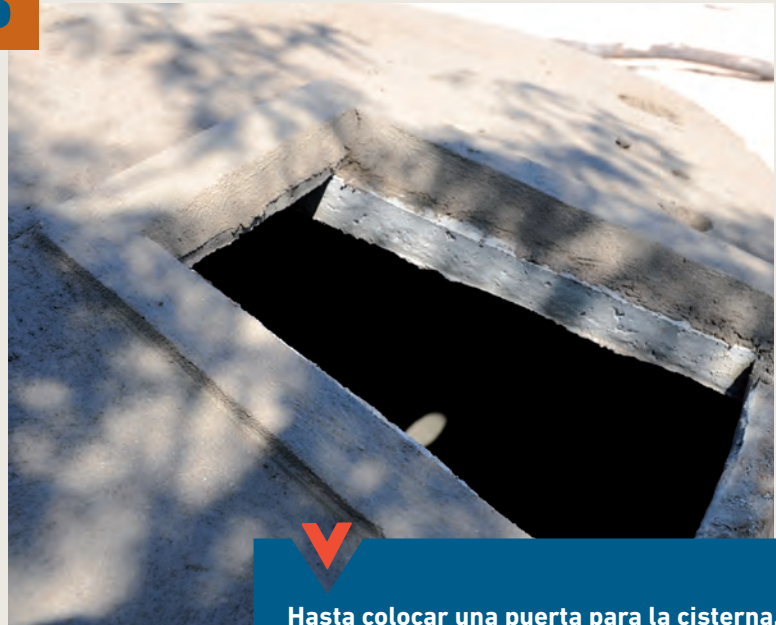
Alrededor de la placa donde se instalará la puerta realizamos una mocheta o marco para evitar que el agua escurra y se meta a la cisterna directamente desde arriba, la protege de la tierra y facilita la colocación de la puerta.
