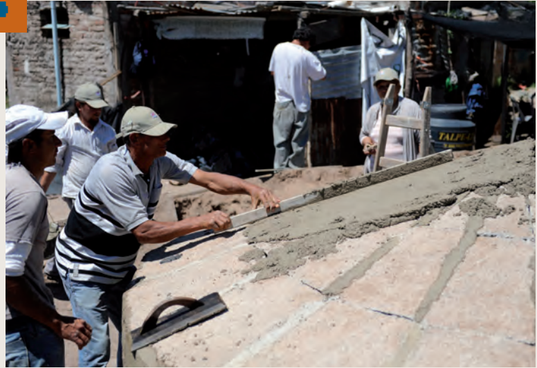
Completamos el revoque de toda la cisterna con el mismo material.
