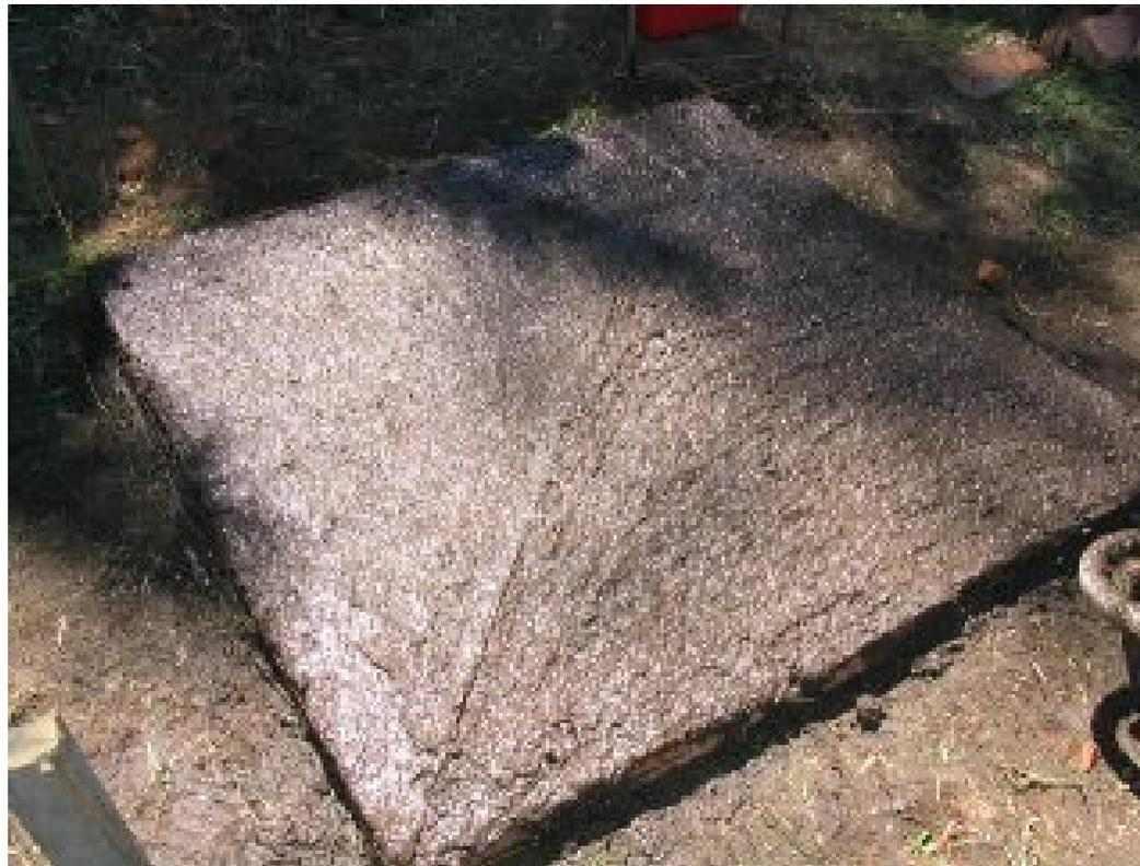
**MEDIMOS 12 CM. DE CADA LADO DE LA BASE PARA QUE EL HORNO NOS QUEDE DE 1,10 M. X 1 M.**
