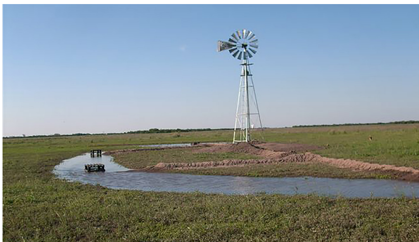
Figura 4. Anillo concentrador del agua de lluvia para efectuar la recarga al acuífero con las perforaciones.
