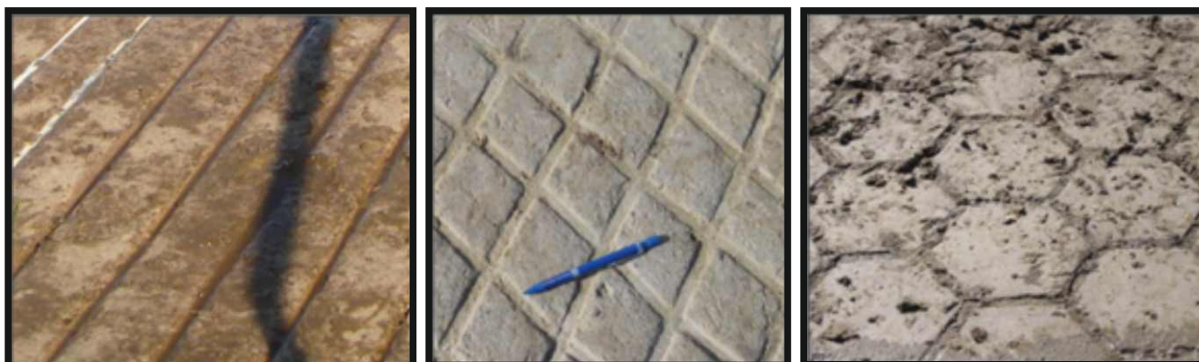
Figura 24. Pisos con ranuras paralelas (foto izquierda), cruzadas (foto central) y hexagonal (foto derecha). (Fuente: INTA)..
