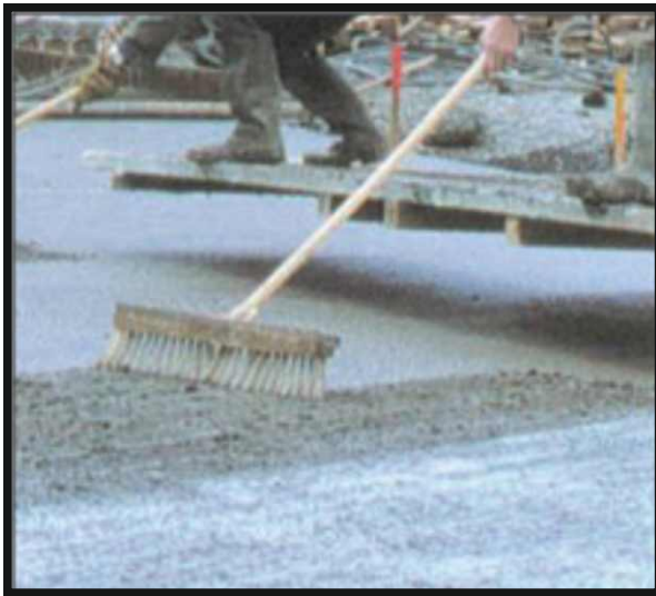
Figura 20. Texturizado del hormigón fresco con cepillo. (Fuente: GIE Lait-Viande de Bretagne, 2010).
