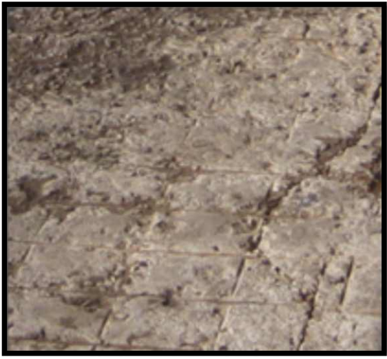
Figura 38. Ranurado por estampado de malla de acero en Corral de Espera. Piso con desgaste por uso.
