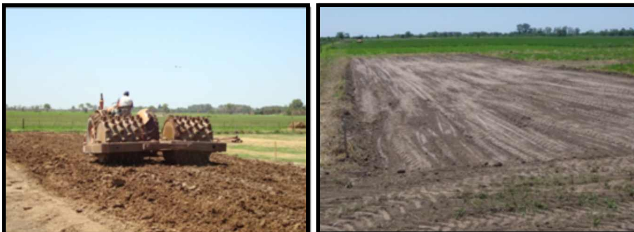
Figura 8. Base de tierra arcillosa (tierra colorada) compactada.
