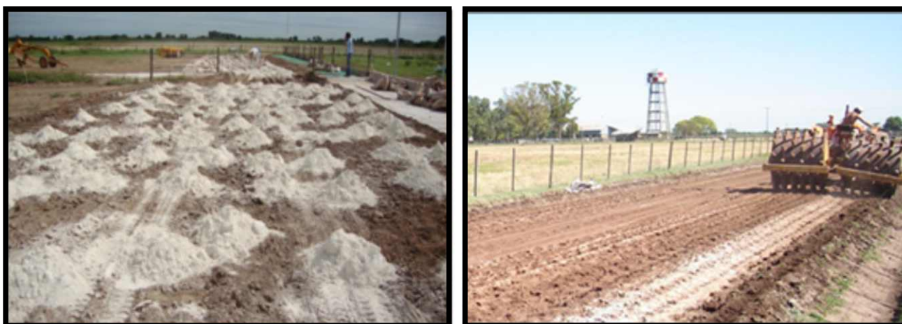
Figura 9. Incorporación de la cal al suelo utilizando rastra de disco y posterior compactado.
