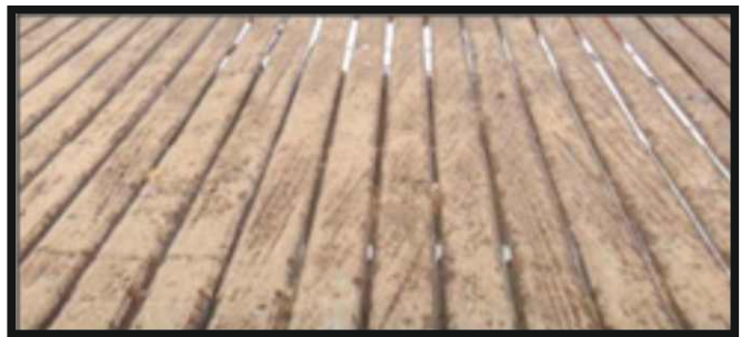
Figura 27. Ranurado paralelo en piso del corral de espera.
