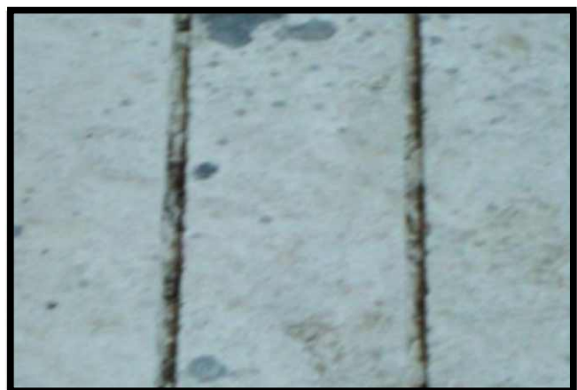
Figura 30. Ranurado con aserradora para pavimentos (foto izquierda). Acabado final de la superficie (foto derecha).
