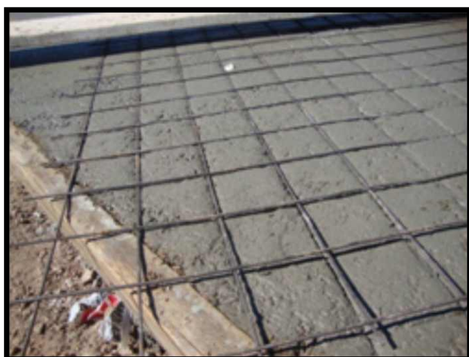
Figura 34. Estampado con malla de acero electrosoldada.
