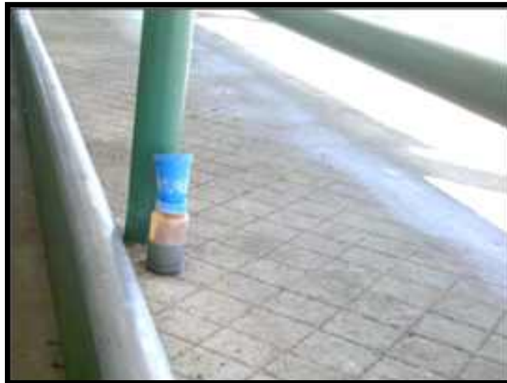
Figura 31. Patrón en forma cuadrada en piso de sala de ordeño. Distancia entre las ranuras: 10 cm; ancho: ~1 cm; profundidad: ~ 0,5 cm. (Foto INTA).
