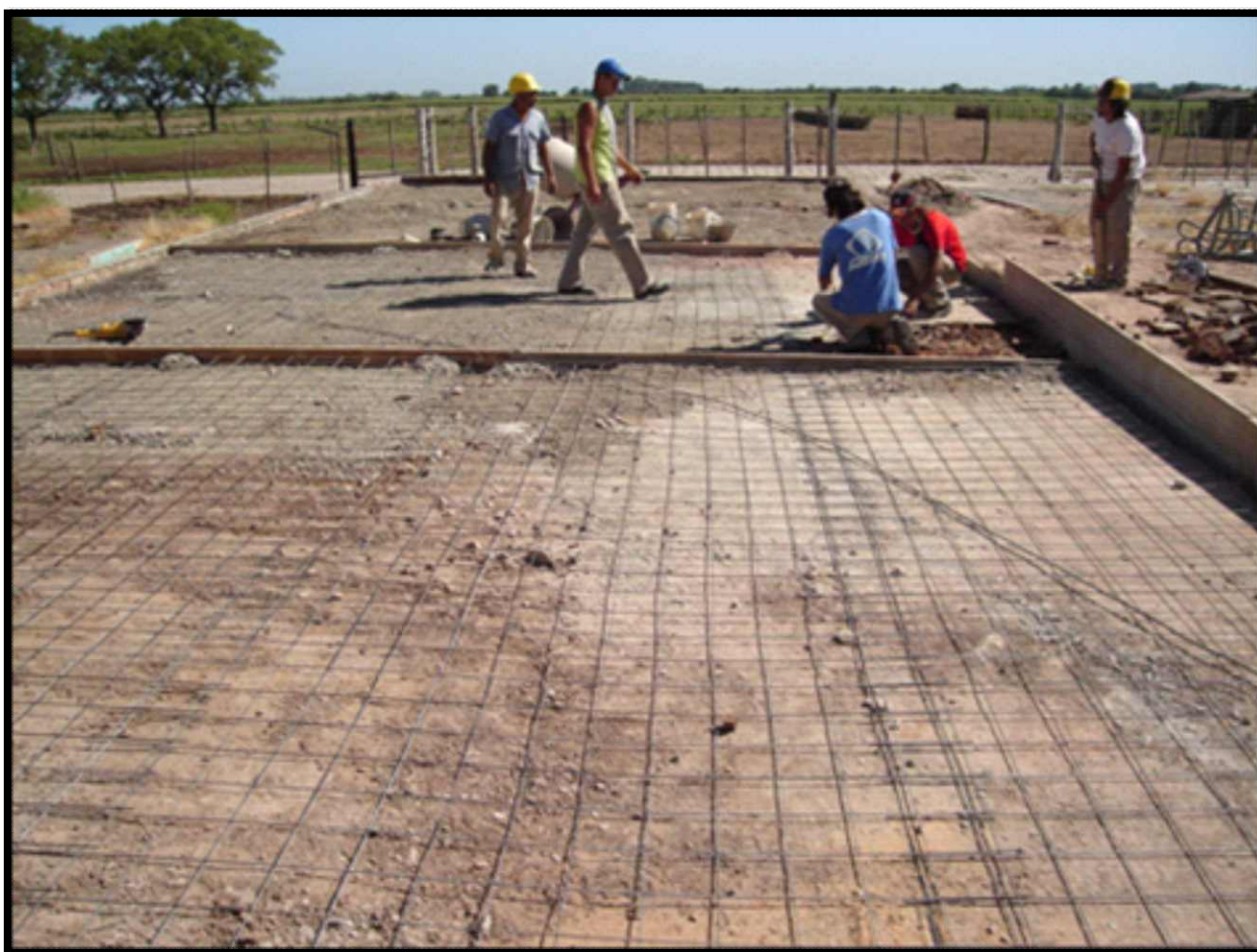
Figura 10. Construcción de piso con malla electrosoldada (Foto INTA).
