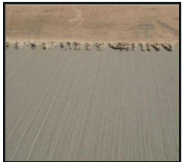
Figura 21. Texturizado del hormigón fresco con tela de arpillera humedecida (Fuente: ICPA, 2013).
