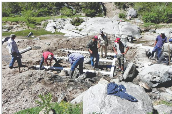
Construcción toma y conducción de agua para riego.
