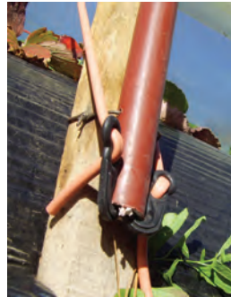
Foto N°19: vista de ganchos de plástico para sostener el sujetatodo o cable de sujeción agarrados a base de arco plástico.
