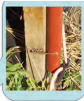
Foto N°17: vista de la sujeción de la cobertura en cada arco con tubo antifleameo.
