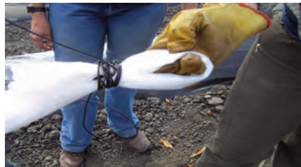
Foto N° 12: detalle ojal armado en cobertura plástica, lista para atado a estaca.
