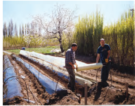
Foto N°15: despliegue de la cobertura sobre los arcos.
