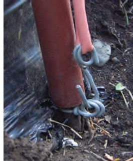
Foto N°18: vista del gancho de alambre para sostener el sujetatodo o cable de sujeción y ojal atado a estaca de hierro.
