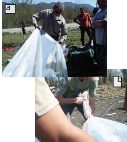
Foto N° 11: a) detalle armado pliegue para el ojal. b) tramo plegado para ojal.
