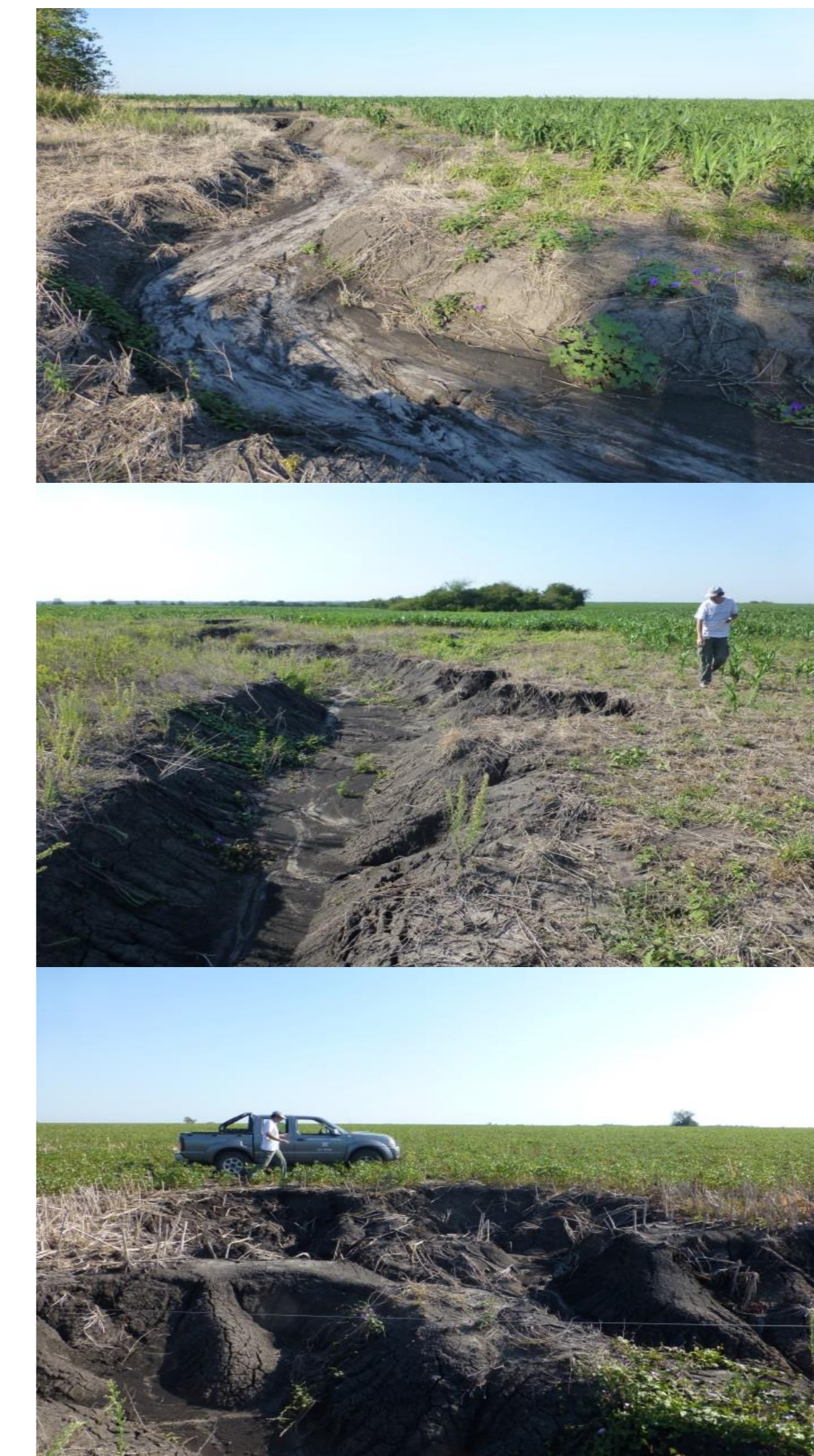
Figura 2: Síntomas de degradación en el campo demostrativo
