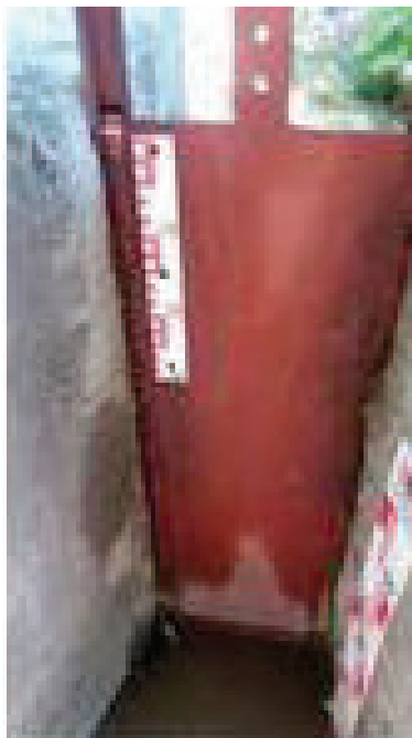
Figura 3: Escalas de aforo en compuerta y mampostería.
