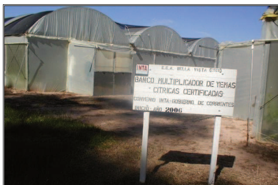
Figura 6- Invernaderos metálicos parabólicos del Centro de Incremento Regional (CIR) de la Estación Experimental Agropecuaria del INTA Bella Vista
