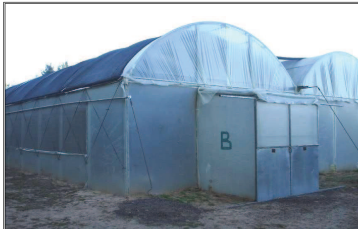
Figura 8- Invernadero con antecámara de desinfección, doble puerta de entrada, malla antiáfidos, techo impermeable y media sombra
