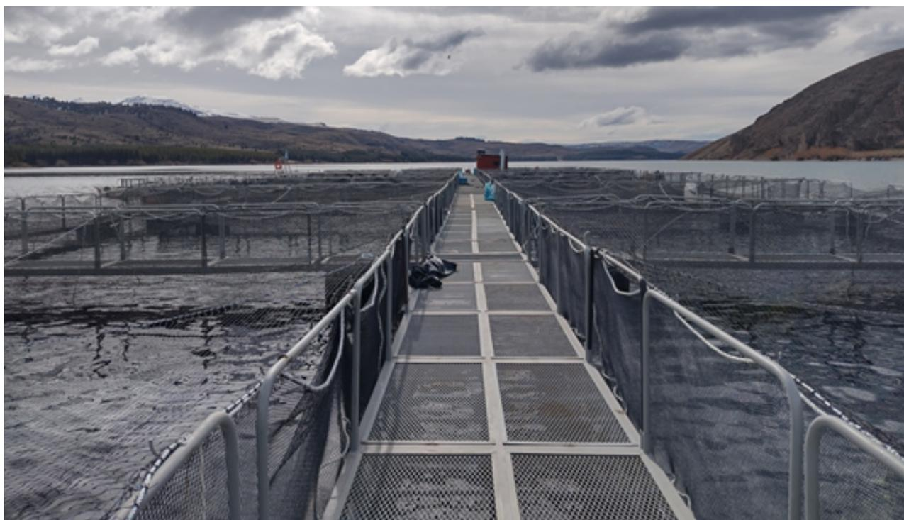
*Fig.3- Sistema de jaulas flotantes: pasarela y baranda.*
