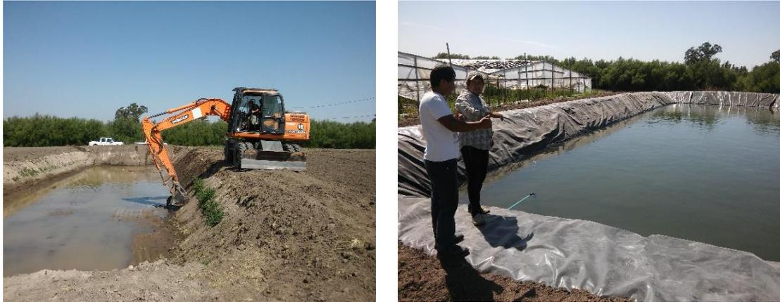
Figura 6. Reservorio de agua para riego por goteo, 500 m<sup>3</sup> de capacidad, Juan A. Pradere.
