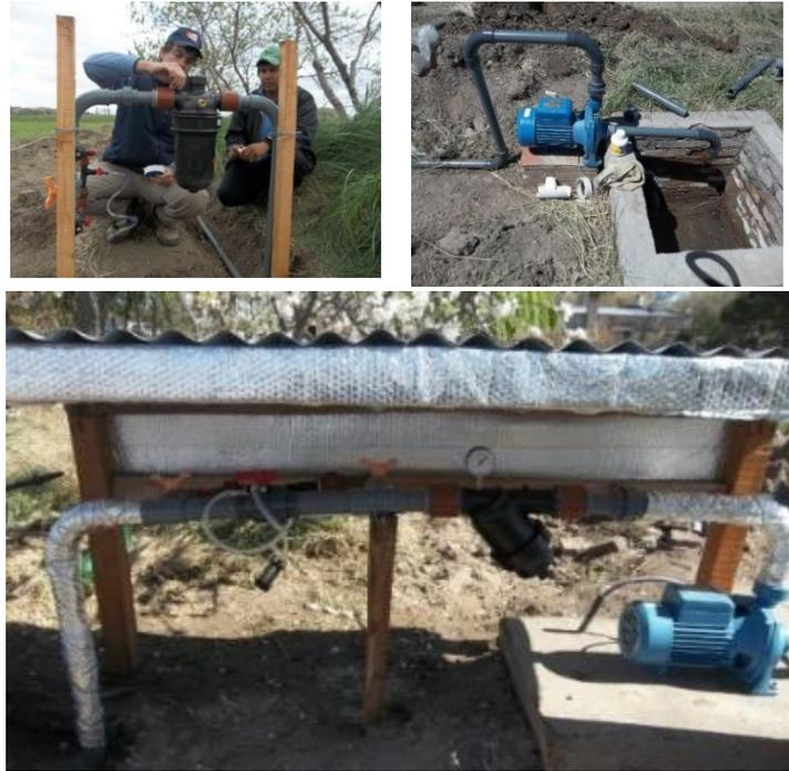
Figura 3. Armado de cabezales de riego por goteo en Juan A, Pradere, 2013 - 2014.
