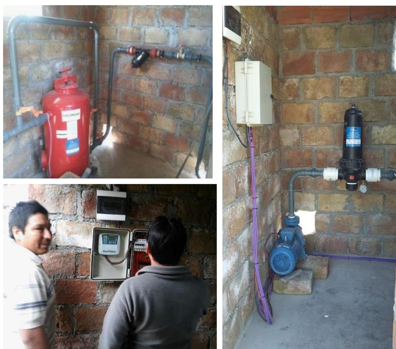
Figura 7. Mejoras en los cabezales de riego, filtros de grava y automatización mediante programadores de riego y electroválvulas.
