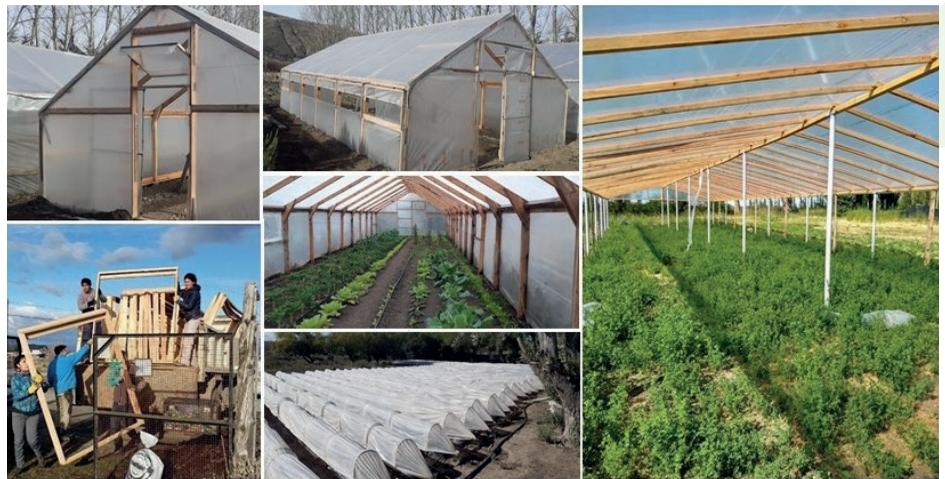
**Figura 1.** Estructuras adaptadas para la provincia de Chubut. Izquierda y centro. Modelo de invernadero modular construido con paneles. Microtúneles (centro abajo), postes reciclados de tubos provenientes de la actividad petrolera (derecha). Fotos: Eduardo Miserendino e Itatí Jones.
