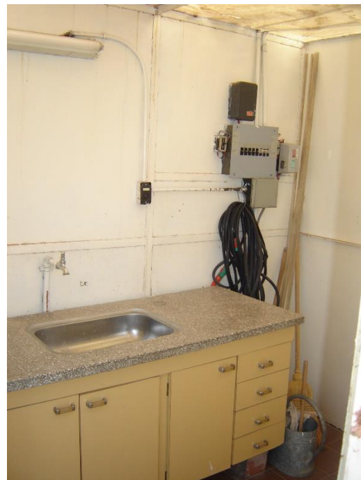
Figura 9 – Vista interna de mesada y pileta
