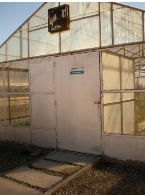
Figura 8 – Vista externa del gabinete sanitario
