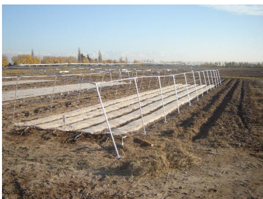
Figura 23 - Vista lateral de la estructura
