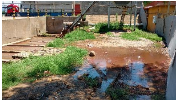
Figura 156. Rebalse de la pileta de sedimentación
