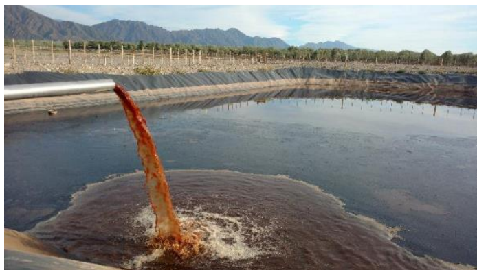
Figura 83. Balsa de evaporación
