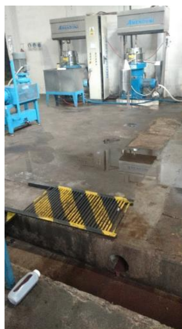
Figura 92. Salida del efluente líquido en canaleta
