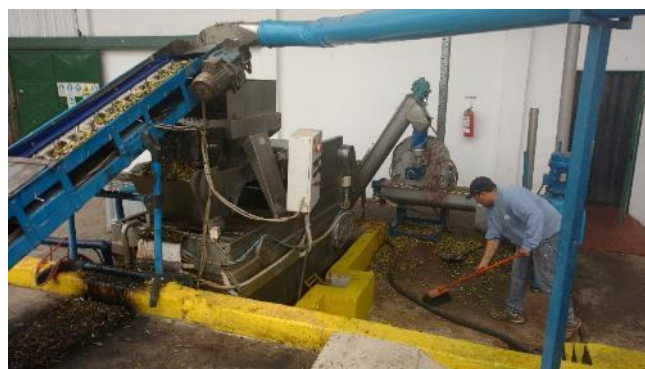
Figura 88. Limpieza del piso e instalaciones del patio
