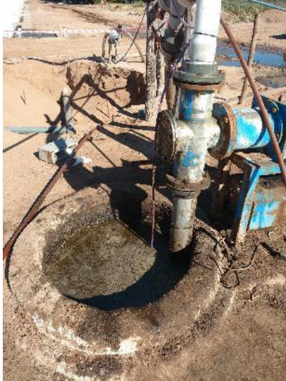
Figura 121. Colmatación de cámara previo al bombeo de la balsa
