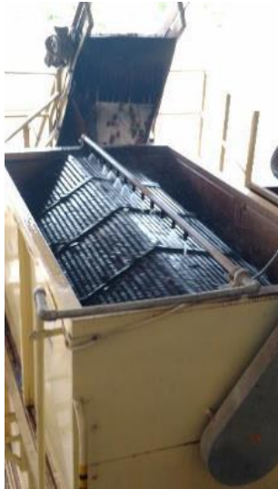
Figura 139. Circulación de agua sin uso aparente
