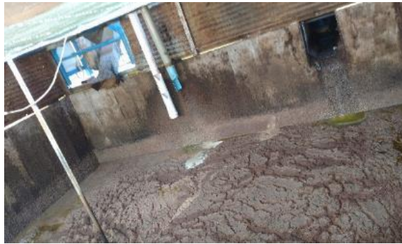
Figura 93. Pileta de disposición de alperujo y efluentes líquidos
