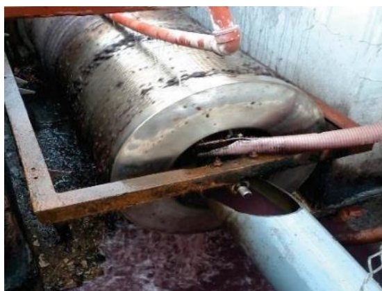
Figura 53. Cilindro separador de gruesos
