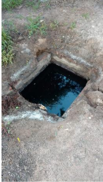
Figura 60. Cámara donde llegan los efluentes
