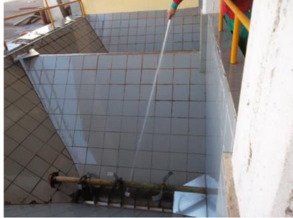
Figura 57. Arreglo provisorio en conducción Figura 58. Utilización de manguera con baja presión
