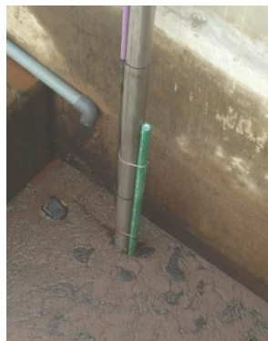
Figura 24. Aforo volumétrico indirecto por bomba de achique
