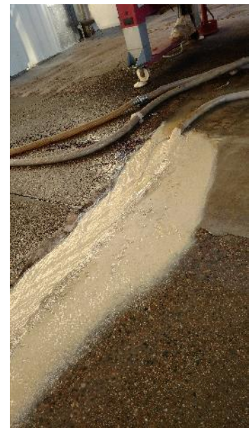
Figura 65. Efluente de la limpieza del filtro al vacío
