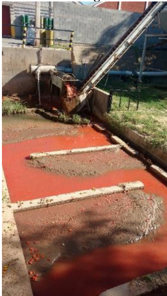
Figura 157. Acumulación de sólidos y barros
