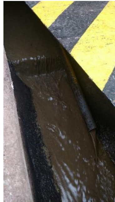
Figura 98. Canaleta con efluente líquido
