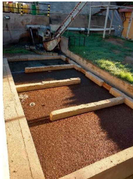
Figura 158. Acumulación de sólidos y barros
