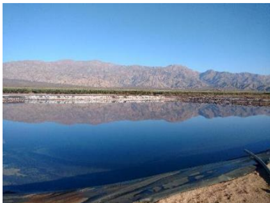
Figura 113. Balsa de evaporación
