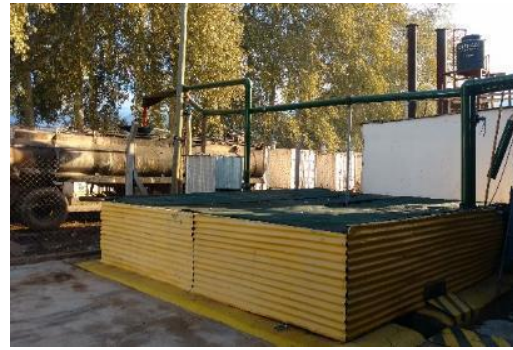
Figura 94. Vaciado de la pileta
