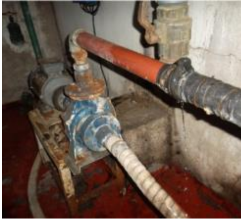
Figura 57. Arreglo provisorio en conducción Figura 58. Utilización de manguera con baja presión
