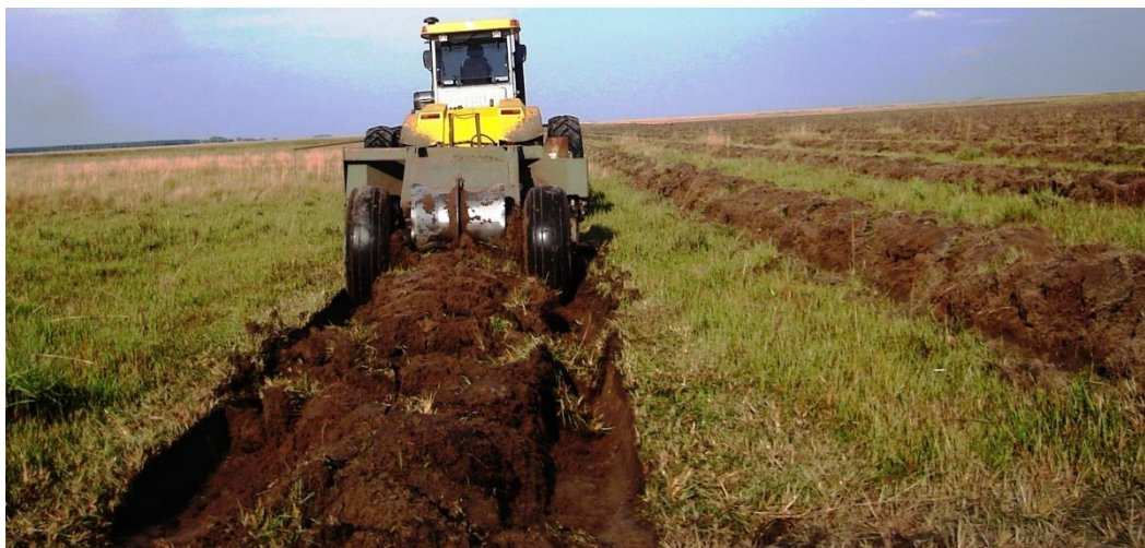
Figura 3: Detalle de labores de roturación del terreno con drenaje deficiente.
