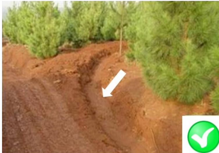
Figura 3: Desagües de las cunetas hacia el interior de las plantaciones.
