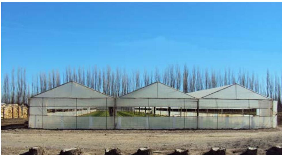
**Foto 36.** Invernadero metálico triple capilla. Ventilación por cortinas de enrollar en las 4 caras. Allen, Río Negro.
