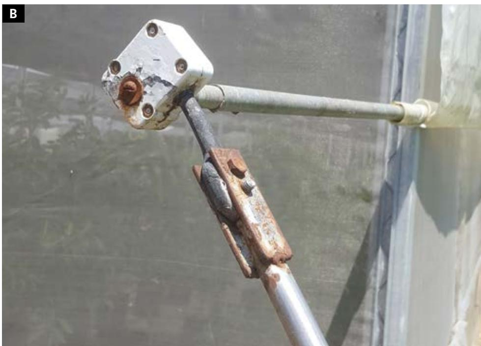
Fotos 18 A y B. Apertura cenital enrollable a manivela (A). Detalle de la caja reductora (B).
