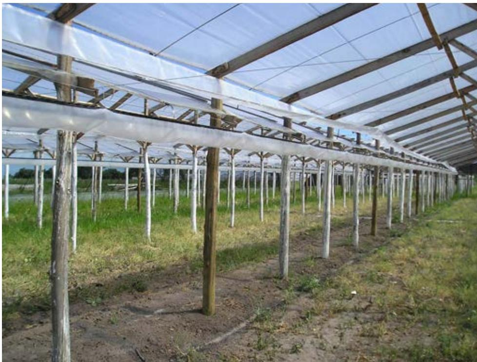
**Foto 7.** Resolución de una canaleta con una lámina de polietileno suspendida en el interior del invernadero.
