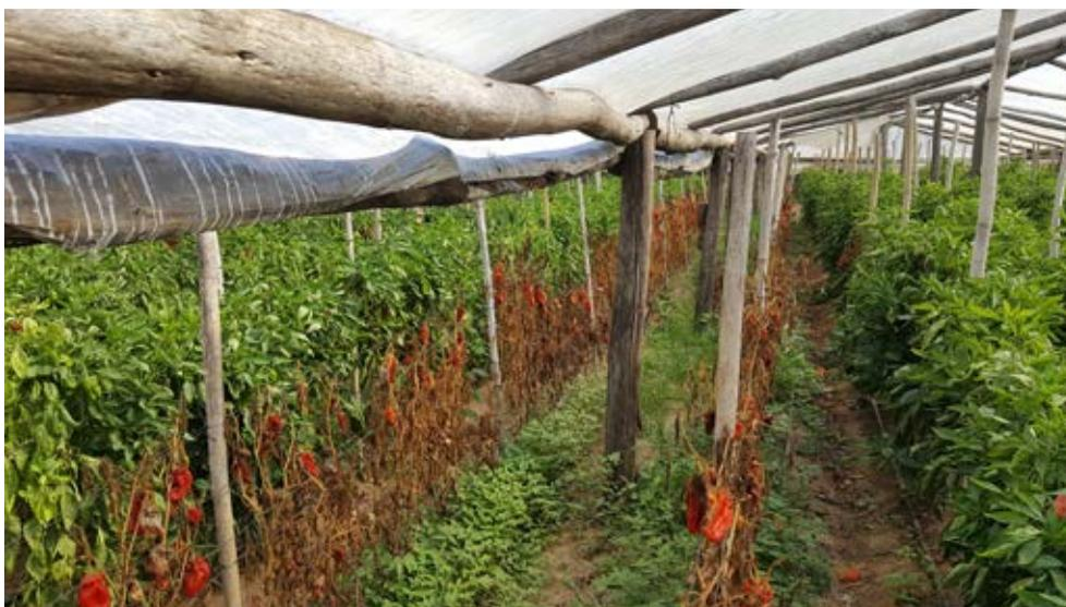
**Foto 4.** Ausencia de canaleta en el empalme entre invernaderos, con pérdida total de una línea de cultivo y enmalezado en la zona de caída de agua de los techos.
