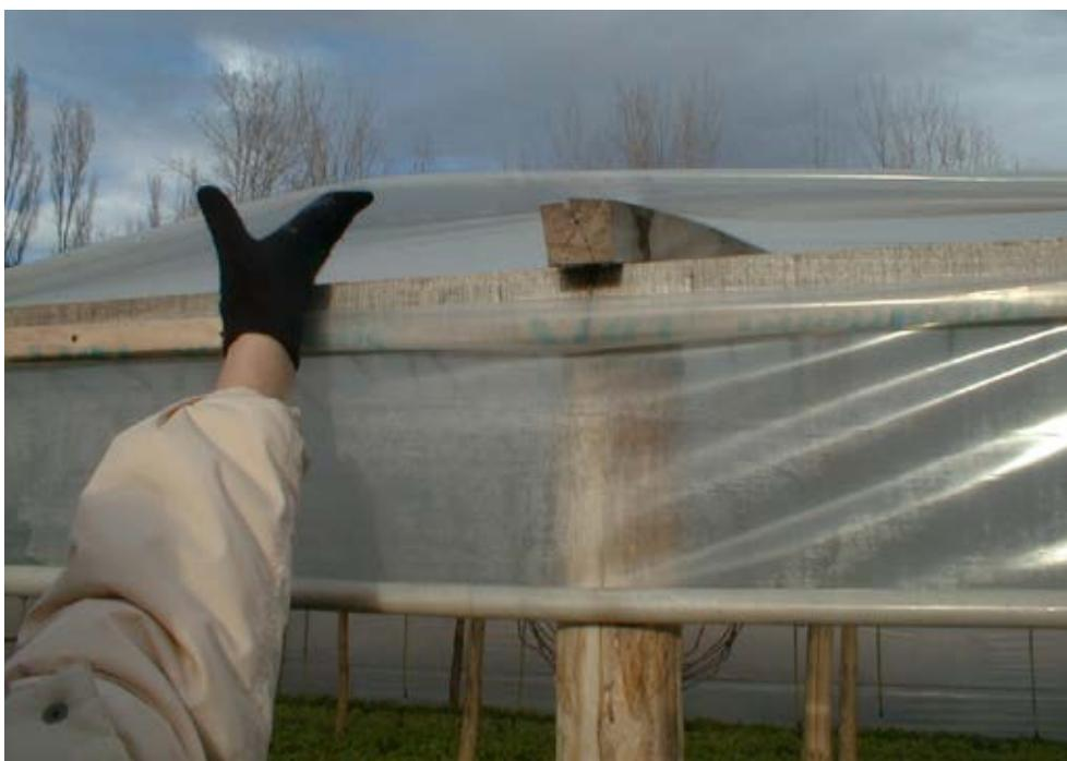
Foto 12. Empalme de la cubierta del techo y laterales con serios problemas de pérdida de calor.
