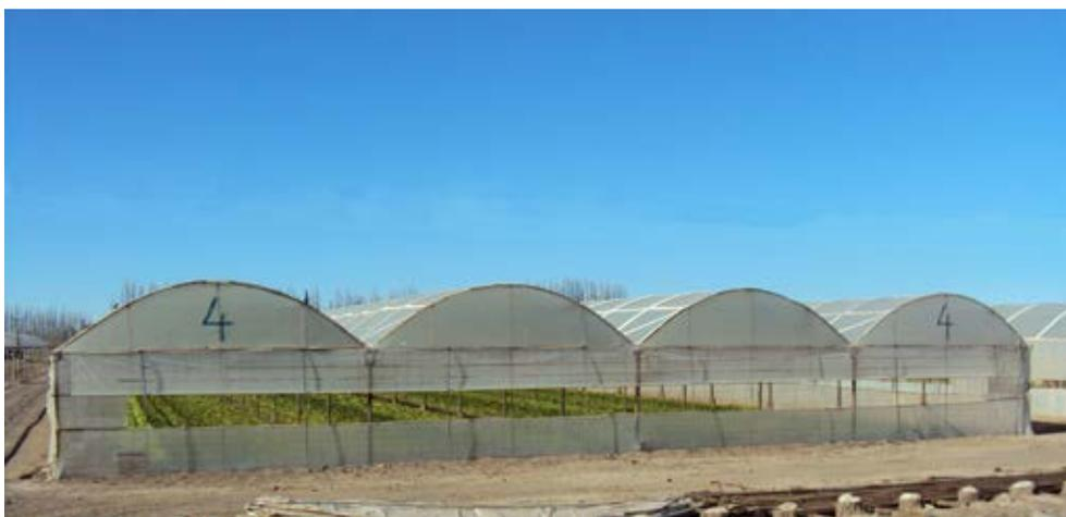
**Foto 37.** Invernadero metálico de cuatro módulos de techo curvo. Ventilación por cortinas de enrollar en las 4 caras. Allen, Río Negro.
