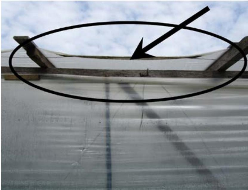
**Foto 35.** Sistema de montaje de cubierta NO RECOMENDADO para la región patagónica.
