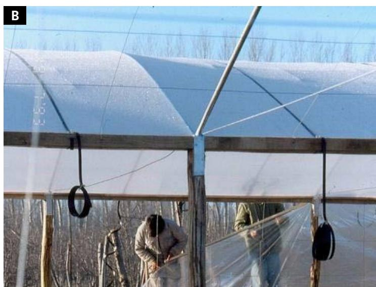
Fotos 14 A, B. Colocación del plástico en los laterales.
