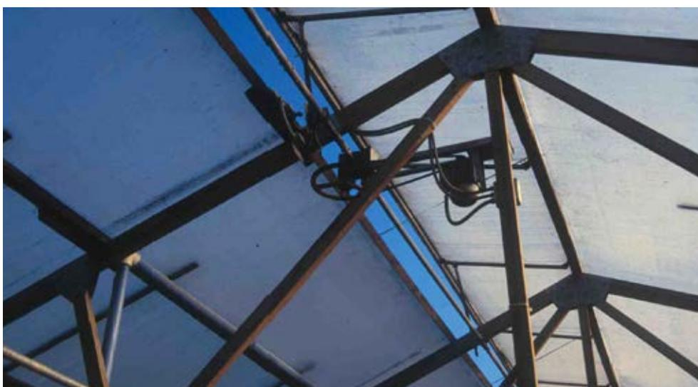
Foto 17. Apertura cenital mecanizada.
