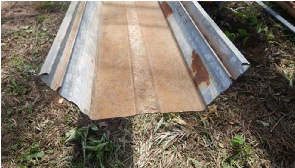
**Foto 5.** Perfil de una canaleta metálica trapezoidal.
