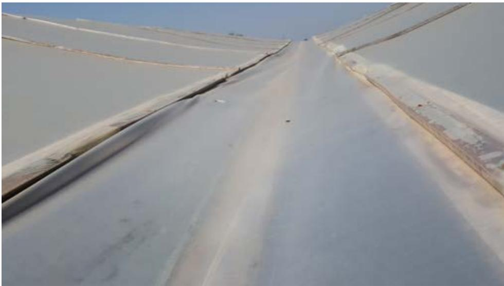
**Foto 6.** Perfil de una canaleta de PE con forma parabólica.
