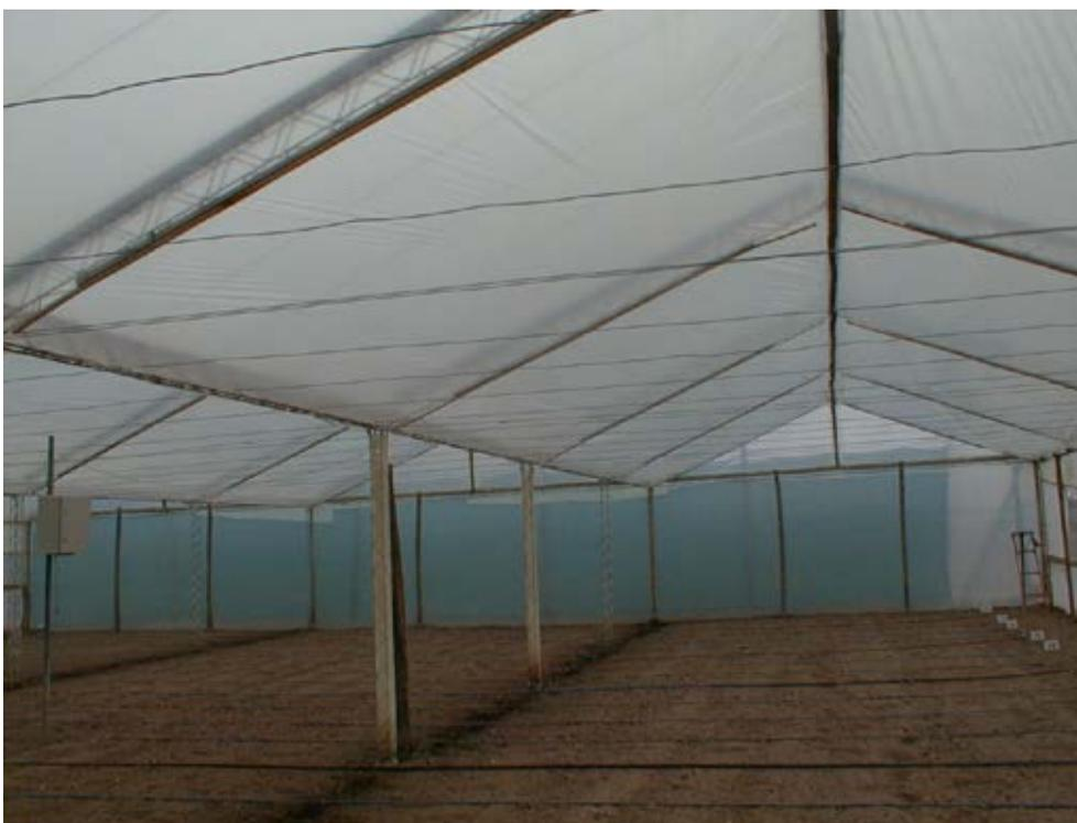
**Foto 39.** Interior invernadero metálico triple capilla con doble capa de techo. INTA EEA Alto Valle. Allen, Río Negro.
