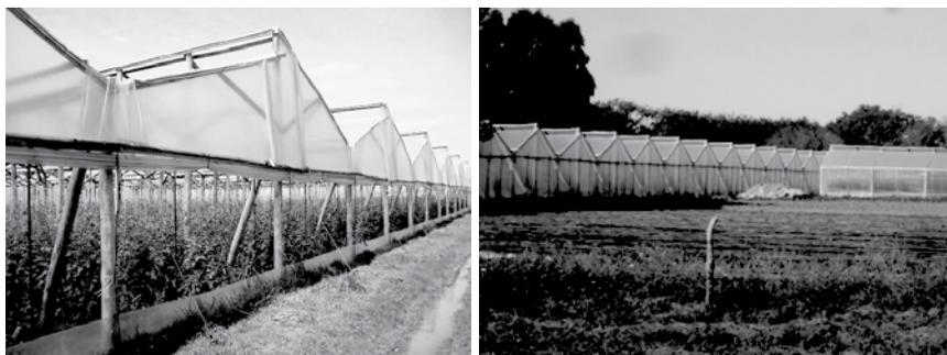
**Figura 36. VC:** Estructura a dos aguas con Ventilación Cenital
