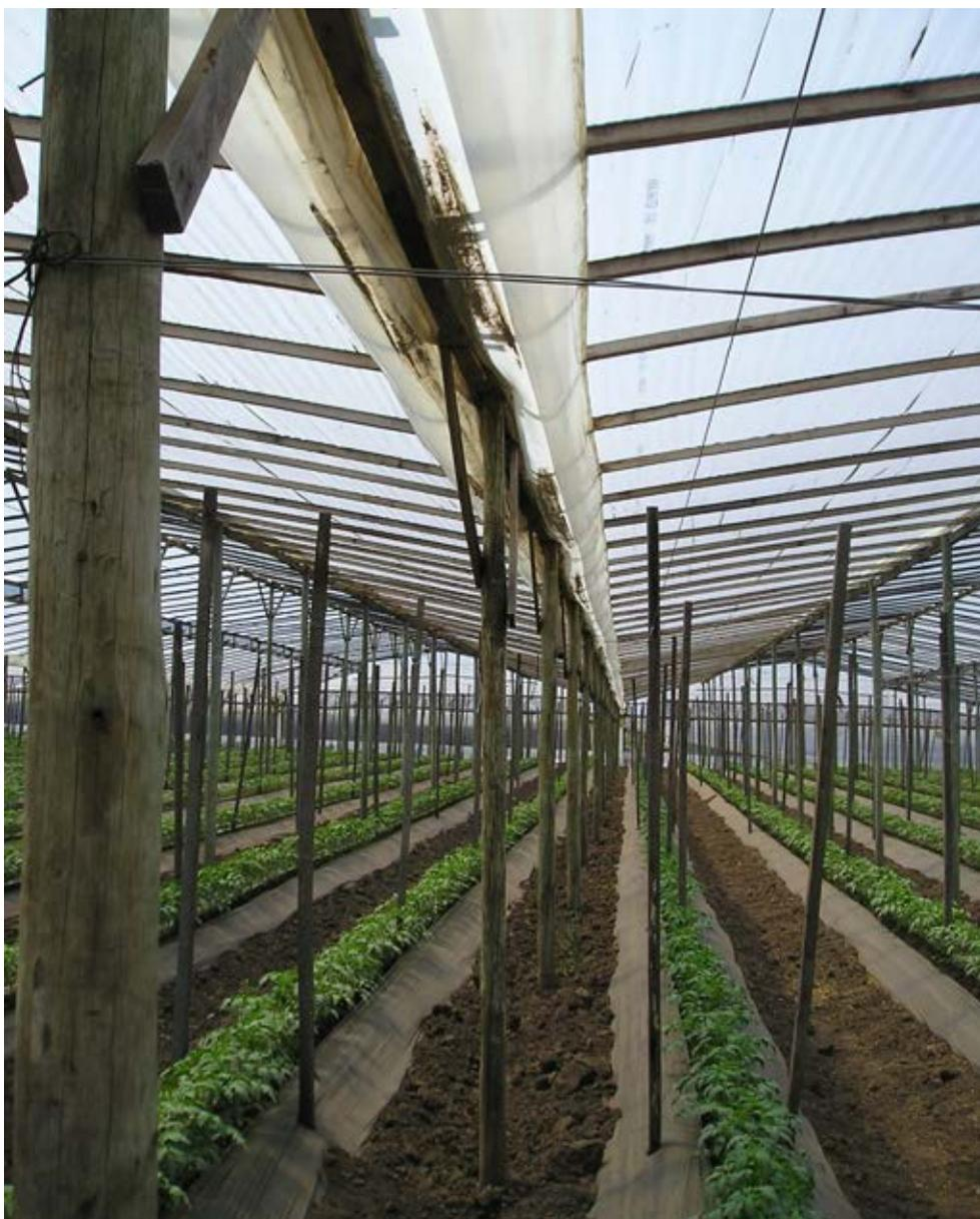
**Foto 8.** Canaleta construida en el interior del invernadero unida a dos alambres longitudinales y soportada en la base mediante parantes verticales y longitudinales de madera.
