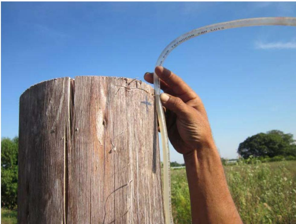
Foto 1. Nivel de manguera para nivelar los postes extremos.
