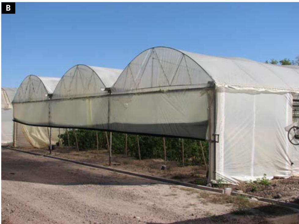
**Foto 26.** Invernadero tipo "Techo Curvo" (TC). A) solo b) con tres módulos acoplados.
