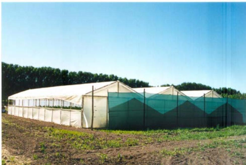
**Foto 38.** Invernadero metálico triple capilla con malla rompevientos en las caras oeste y sur. INTA EEA Alto Valle. Allen, Río Negro.
