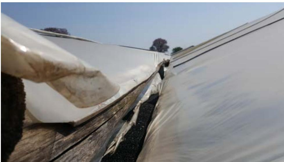
**Foto 3.** Canaleta totalmente rota por defecto de construcción.
