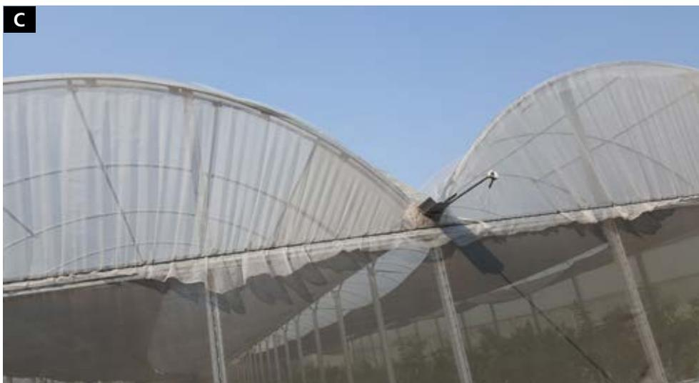
Foto 23. A) Malla antiáfidos al costado de la estructura; B) Puerta doble; C) Ventilación cenital con malla colocada.
