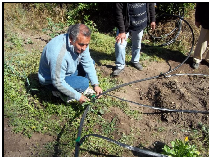
Figura 33: Esta fotografía muestra a los agricultores en plena tarea de conectar válvulas en una línea secundaria. El sistema de riego es por goteo.
