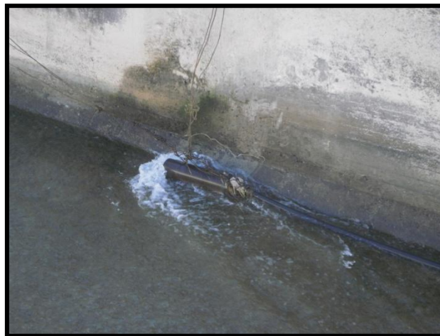
Figura 36: Aquí puede verse el sifón captando el agua.
