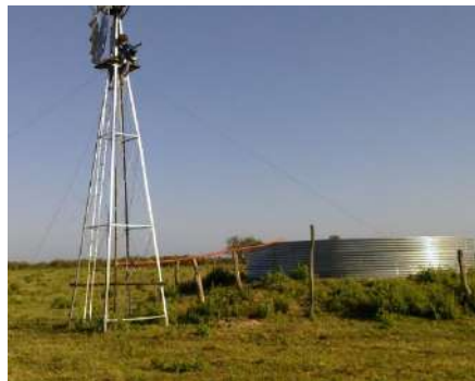
Figura N.º 5. Molino de viento con tanque australiano.
