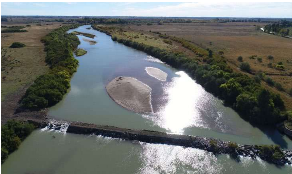
Figura N.º 7. Estación de aforo Paso Alsina, Buenos Aires. (CORFO).
