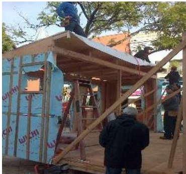
(D) Día 3: Aislación de techos y muros exterior – aislamiento interior con lana de vidrio.
