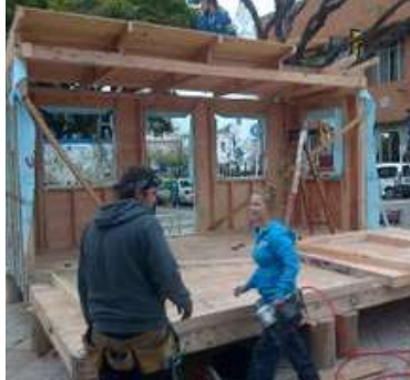
(B) Día 2: Muros 2 y 3 fijos con aislante y cerchas – colocado de fenólico-bisagra de techo. El muro exterior de la espalda de la vivienda se dividió en dos y no se fijó a la plataforma de piso con el fin de moverlos a mano.
