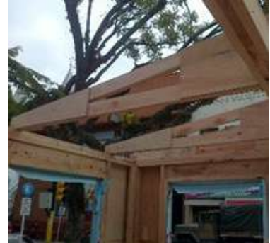
(B) Día 2: Muros 2 y 3 fijos con aislante y cerchas – colocado de fenólico-bisagra de techo. El muro exterior de la espalda de la vivienda se dividió en dos y no se fijó a la plataforma de piso con el fin de moverlos a mano.
