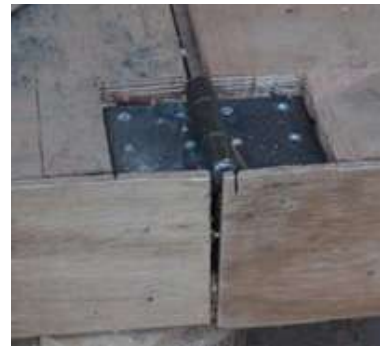
(A) Día 1: Panel de piso fijo – aislación telgopor – fenólico – piso parte plegable.
