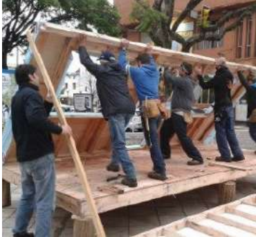
(B) Día 2: Muros 2 y 3 fijos con aislante y cerchas – colocado de fenólico-bisagra de techo. El muro exterior de la espalda de la vivienda se dividió en dos y no se fijó a la plataforma de piso con el fin de moverlos a mano.
