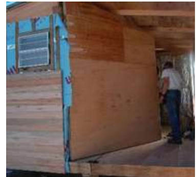
(D) Día 3: Aislación de techos y muros exterior – aislamiento interior con lana de vidrio.
