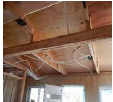
(B) Día 2: Muros 2 y 3 fijos con aislante y cerchas – colocado de fenólico-bisagra de techo. El muro exterior de la espalda de la vivienda se dividió en dos y no se fijó a la plataforma de piso con el fin de moverlos a mano.
