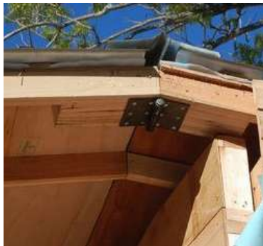
(C) Día 3: Armado del techo Cabriadas – articulación – unión de techos.
