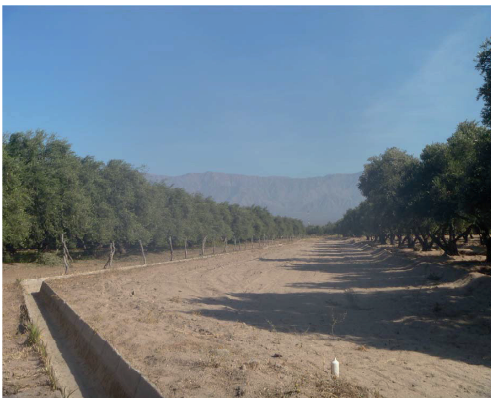
Figura 2.5. Canales de cemento contruidos para riego.
