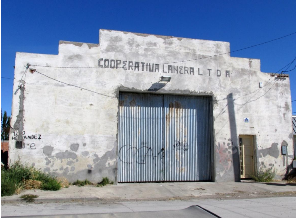
Figura 3.8: Instalaciones de la antigua “Cooperativa de Transformación y Comercialización Lanera y Afines Centro-Oeste del Chubut Limitada”. Sarmiento, 2019. Foto de la autora.
