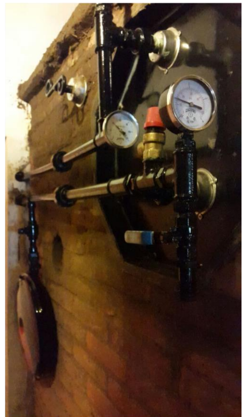
Imagen 16. Estufa BBR8 con sistema de agua de calefacción. Elementos de seguridad. Foto: P. Kulbaba
