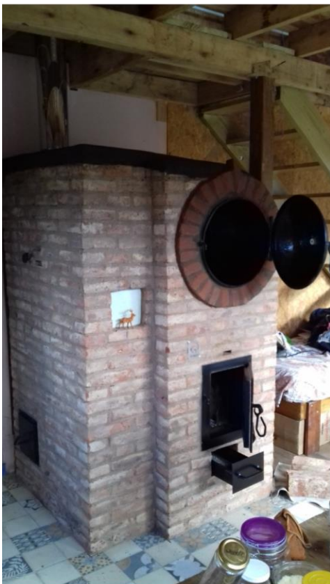
Imagen 15. BBR6L con campana de ladrillos y horno construida en Chascomús, Pcia. de Buenos Aires. Foto: P. Kulbaba
