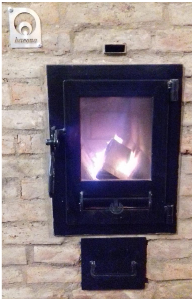
Imagen 23. Puerta de estufa BBR6, con control de aire primario, vidrio cerámico, y manija de cierre con prensado de hoja contra marco. Debajo de la puerta se ve el cajón cenicero.
