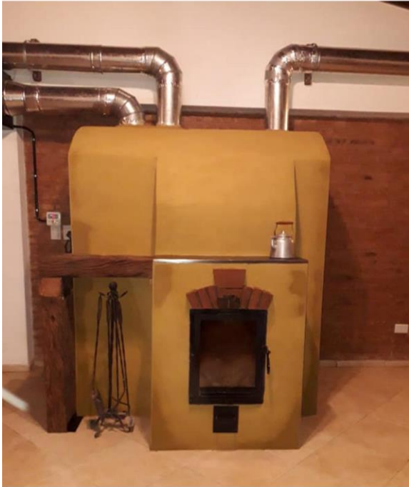
Imagen 13. Estufa BBR9 con sistema de convección forzada. Mercedes, Pcia de Buenos Aires. Foto: P. Kulbaba
