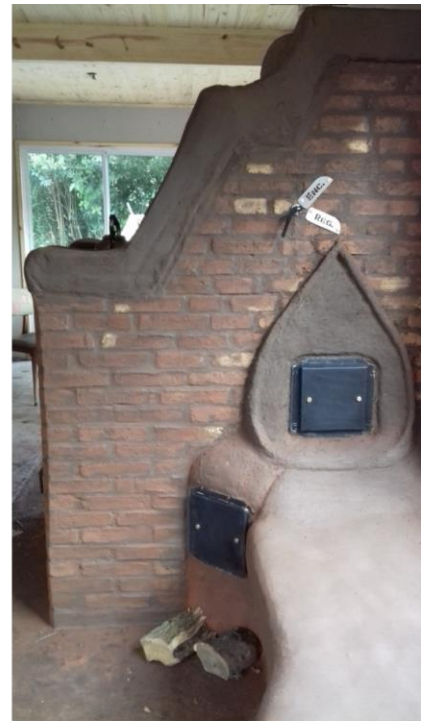
Imagen 14. BBR6 con campana de ladrillos y plancha caliente construida en Chascomús, Pcia. de Bueno Aires. Foto: P. Kulbaba
