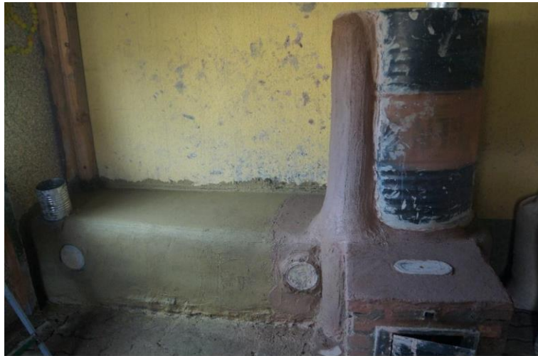
Imagen 24. Estufa BBR8. Detalle de revoque con color sobre banco de masa. Esquel, Pcia de Chubut. Foto: L. Gallo Mendoza
