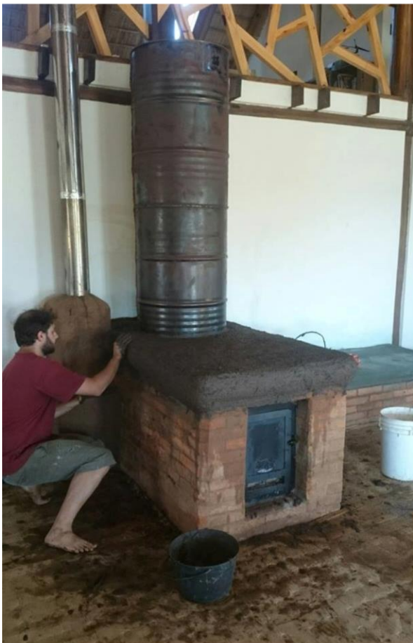
Imagen 11. Estufa BBR8 con doble tambor para maximizar la radiación. Foto: TierraBilú
