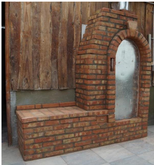
Imagen 10b. Módulo de intercambio de calor en habitación contigua. Estufa instalada en el Club La Frontera, Puelo, Pcia. de Chubut. Fuente foto: L. Gallo Mendoza
