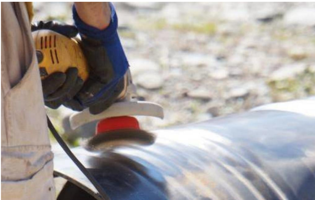
Imagen 25. Trabajos en superficie metálica. Foto: L. Gallo Mendoza
