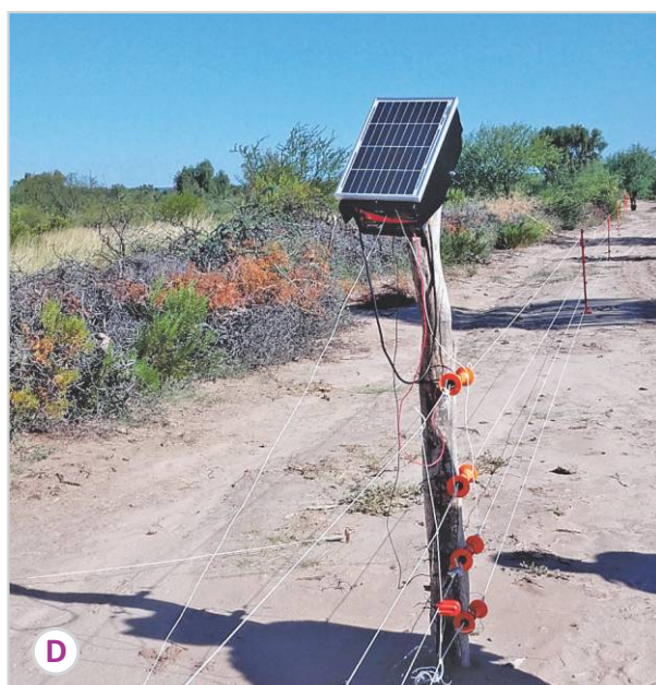
C) y D): Boyero eléctrico instalado en campo de productores.
