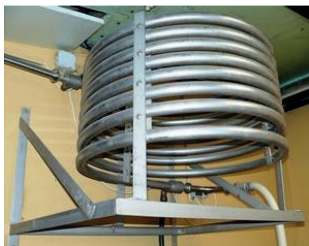
Figura 3. Refrigerador tubular instalado en un tambor (Loobuyck et al, 2012)
