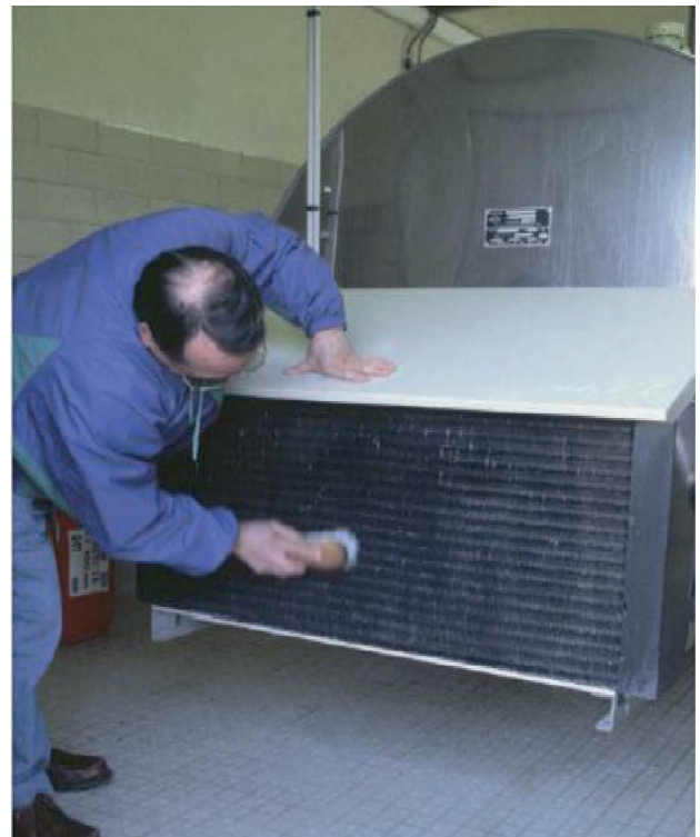
Figura 13. Limpieza de la superficie de intercambio del condensador del equipo frigorífico.
